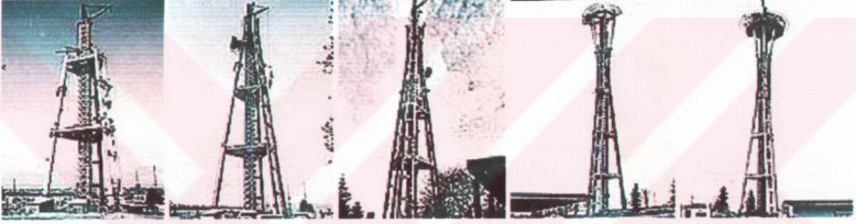
Şekil 3.40 Space Needle'in inşaat evreleri
