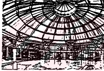
Şekil 3.58 Tüp metal kubbe. (Schmitz ve Csizmadia, 1983)
