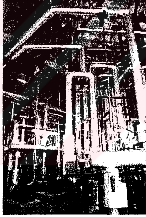
Şekil 4.44 Tesisat sisteminden bir görünüş. (Pamir, 2001)
