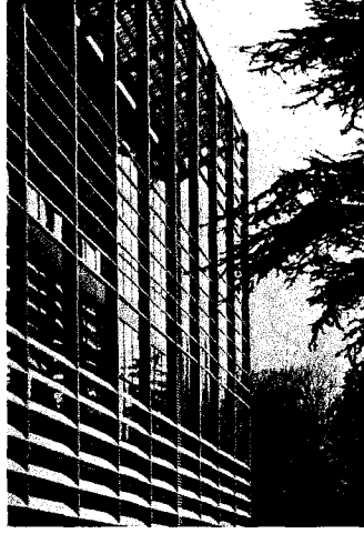
Şekil 4.33 Dikey güneş kırıcıları gösteren dış cephe detayı [21]
