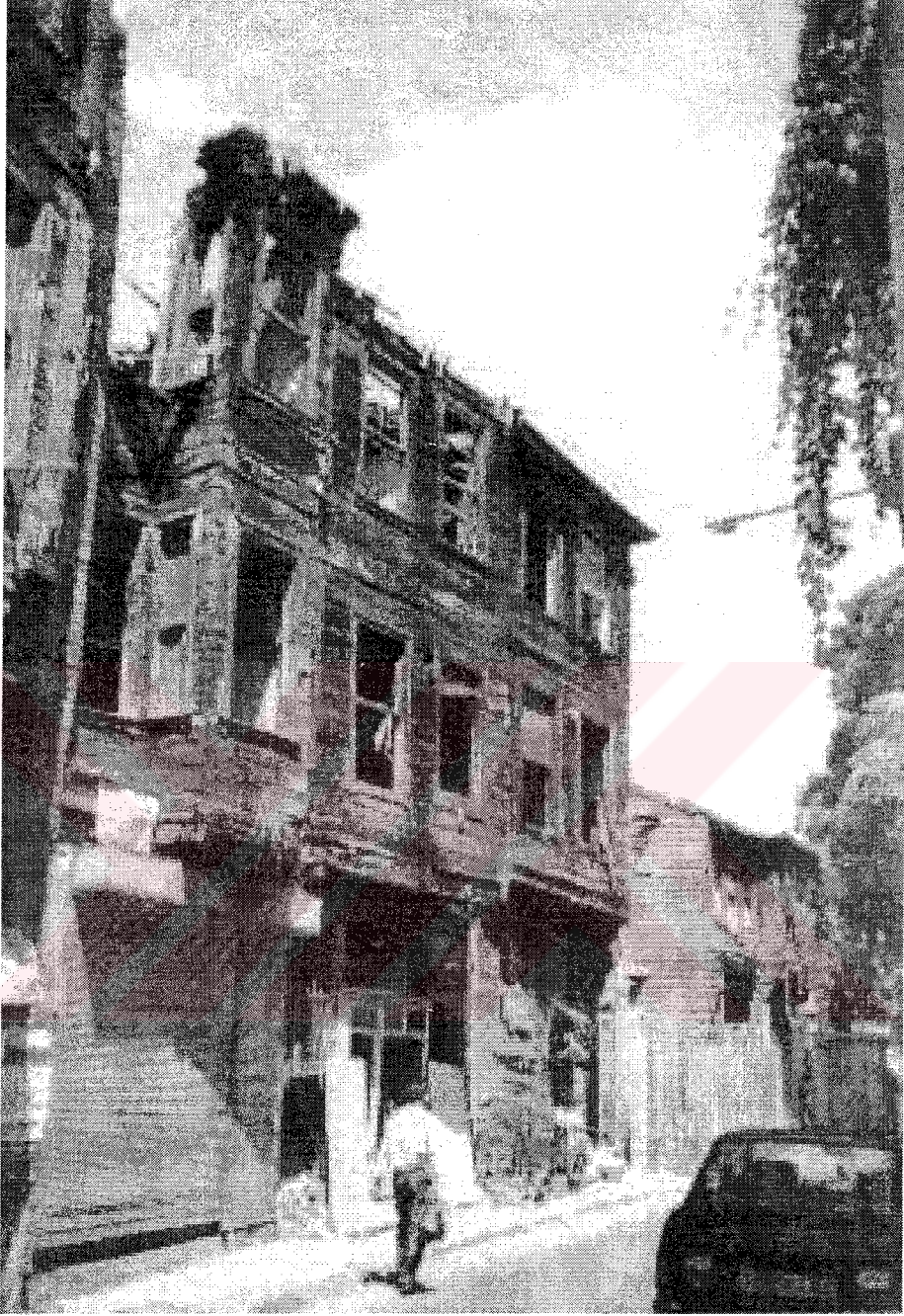
Resim 5.21 Süleymaniye'deki bir konut binasının günümüzdeki durumu (Kuban, 2000)
