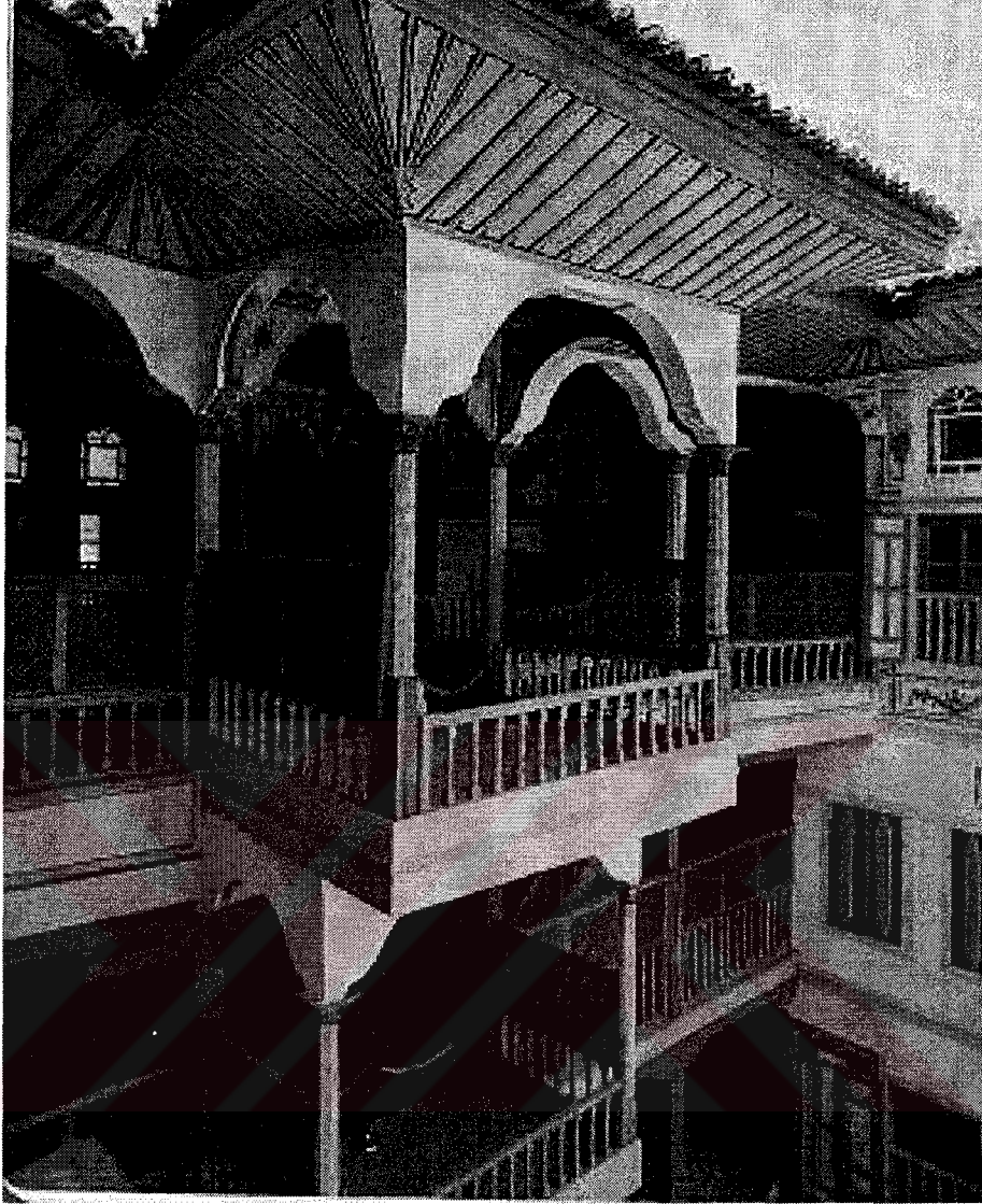
Resim 2.5 Birgi Çakırağa Konağı, restore edilip ziyaretçilere açıldıktan sonra
