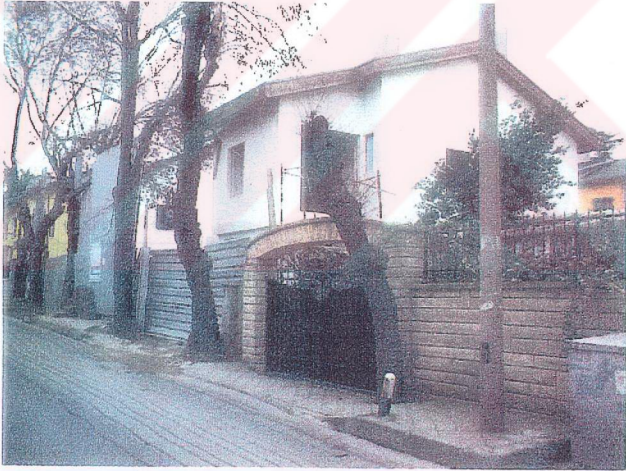
Şekil 3.44 Levent'te bahçe duvarı eklenmiş konutlar
