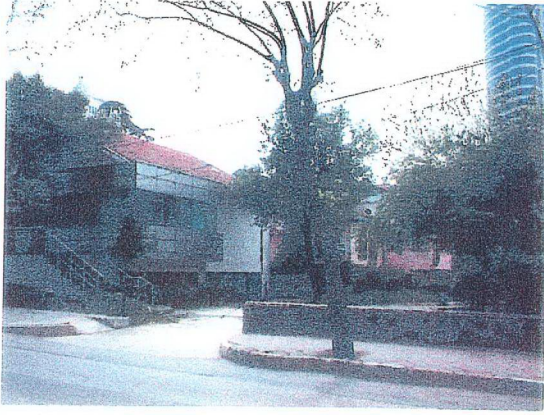
Şekil 3.45 İşyerine dönüşüm sonrası otopark amacıyla betonlaştırılmış bir bahçe
