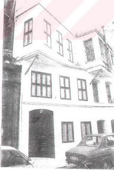
Resim 3.7 Kuzguncuk'ta yaşıyan kültürel orta sınıf tarafından onarım gören binalardan biri: Onarımdan önce (üstte) ve sonra (Bektaş, 1996b)
