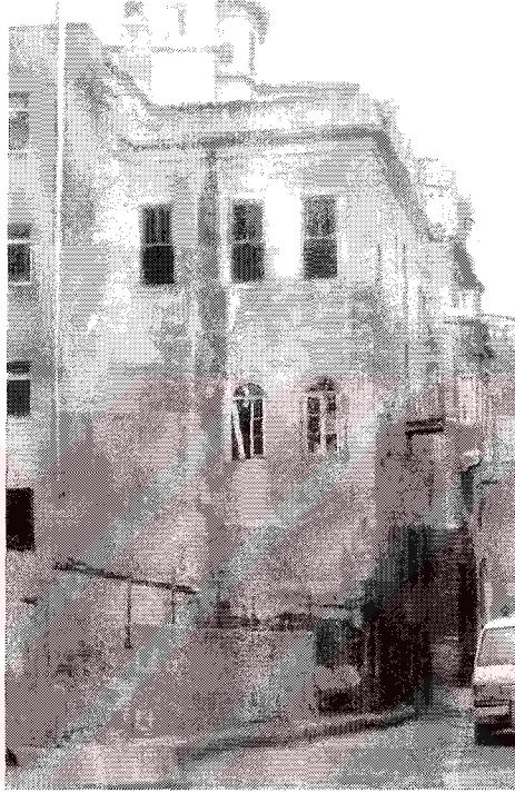
Resim 7.4 Terk edilmiş çok kötü durumdaki yapılardan biri
