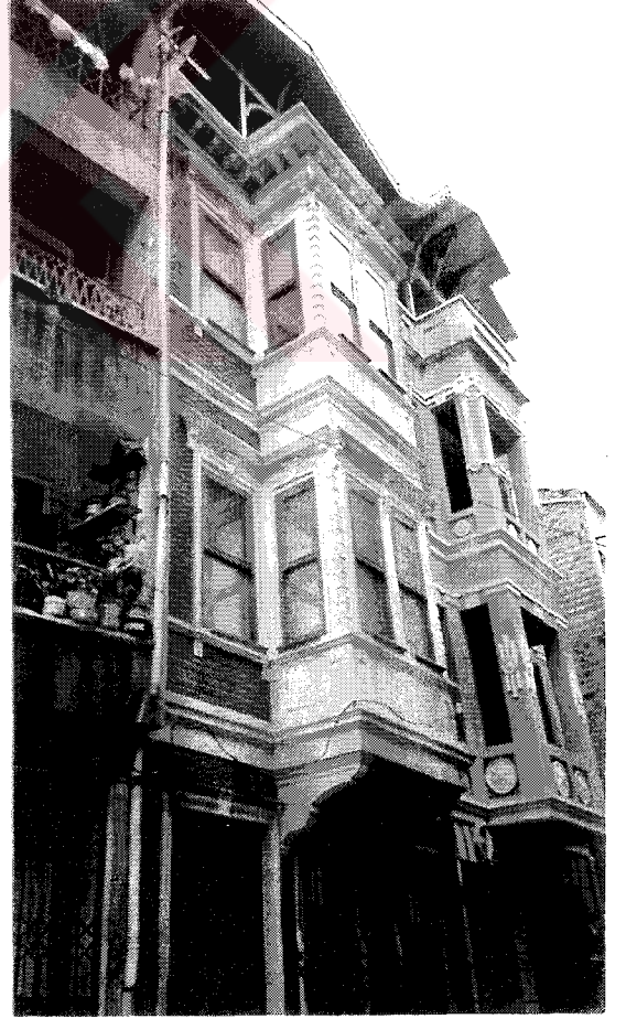
Resim 8.4 Balatta bir soylulařtırıcı tarafından restore edilen ev ve yanında restorasyon halindeki diđer bir bina
