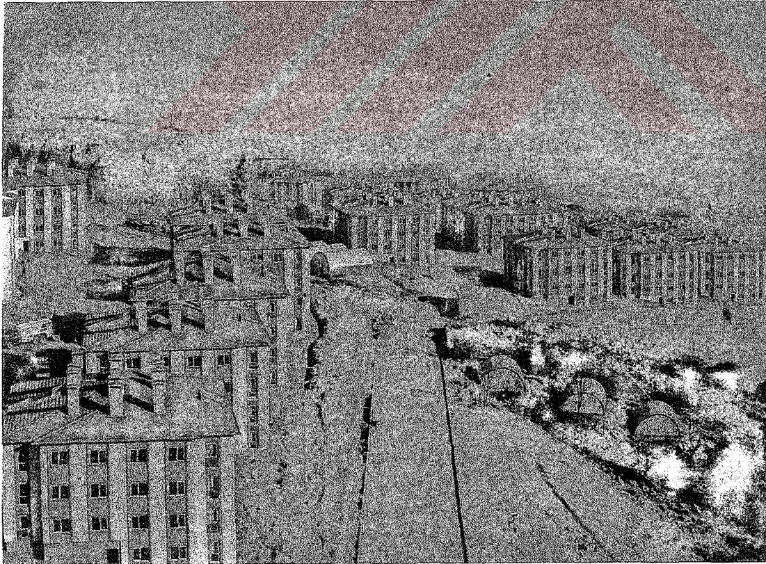
Şekil 5.24 Vinç tepesinden 11 ve 12 ada binalarının kuşbakışı görünüşü
