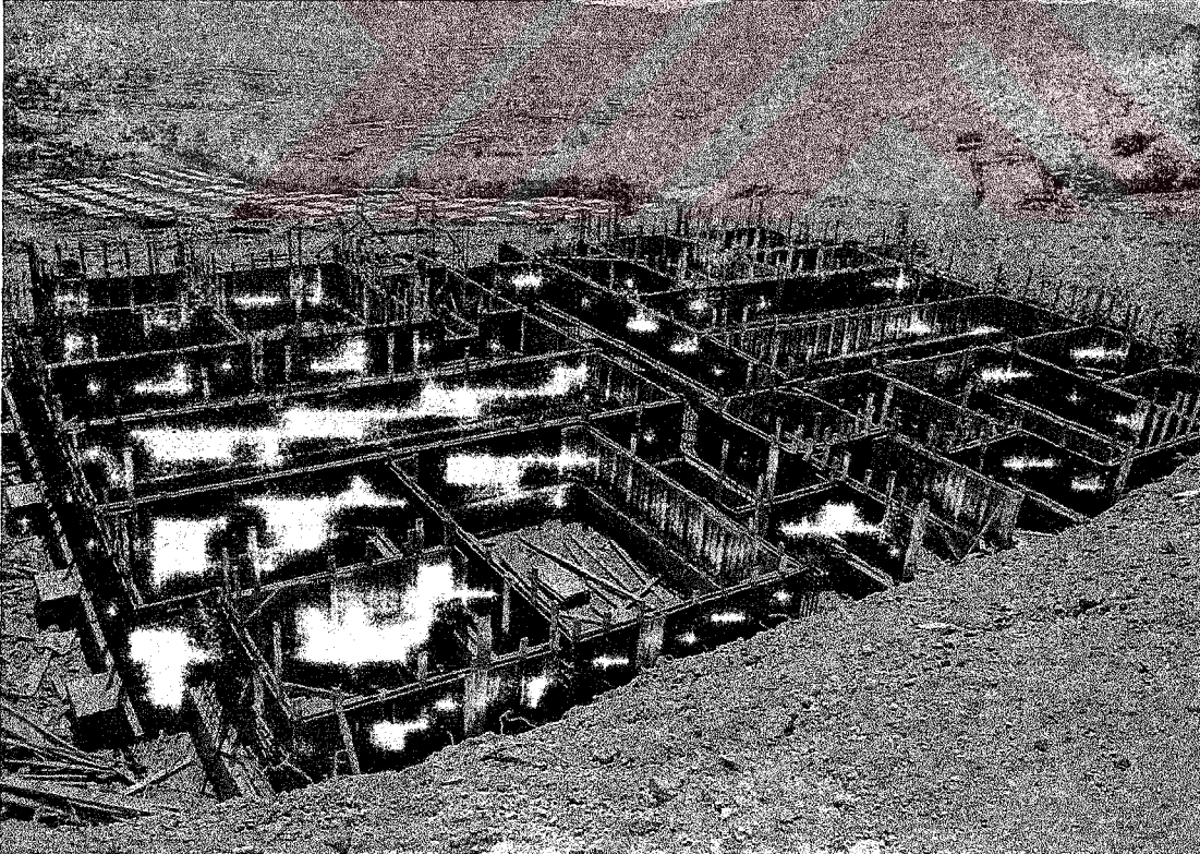
Şekil 5.14 Yükseltme perdesi kalıp imalatı
