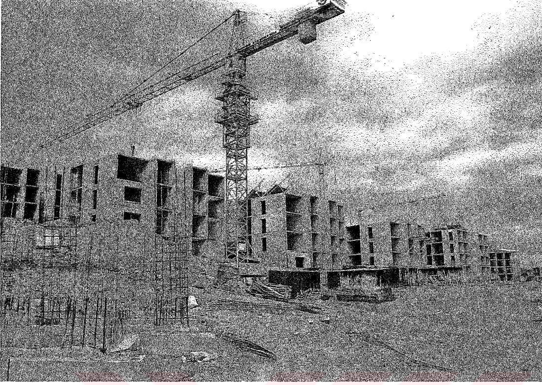
Şekil 5.21 Tünel kalıp ve prekast asımları panoramik görünüşü
