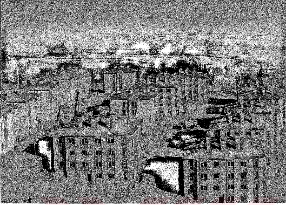
Şekil 5.23 Vinç tepesinden 11 ada binalarının kuşbakışı görünüşü
