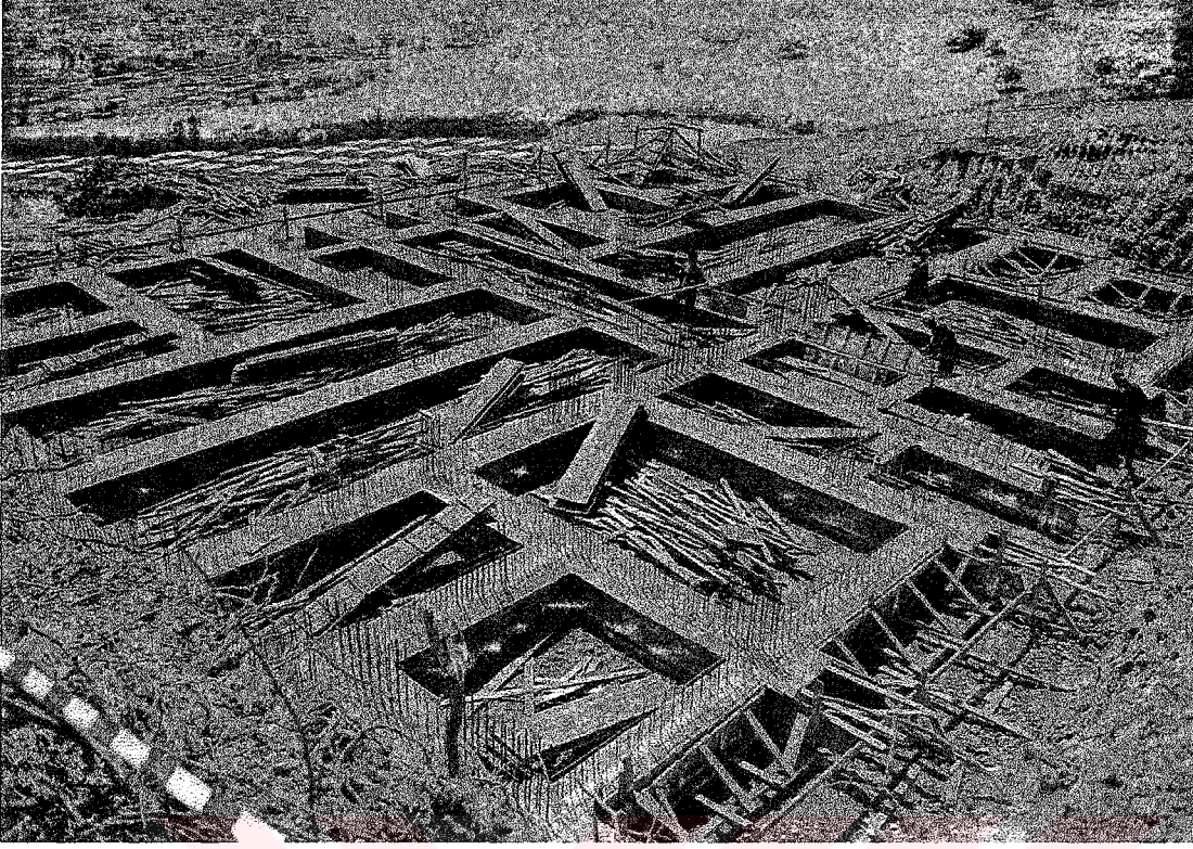
Şekil 5.11 Temel imalat uygulaması
