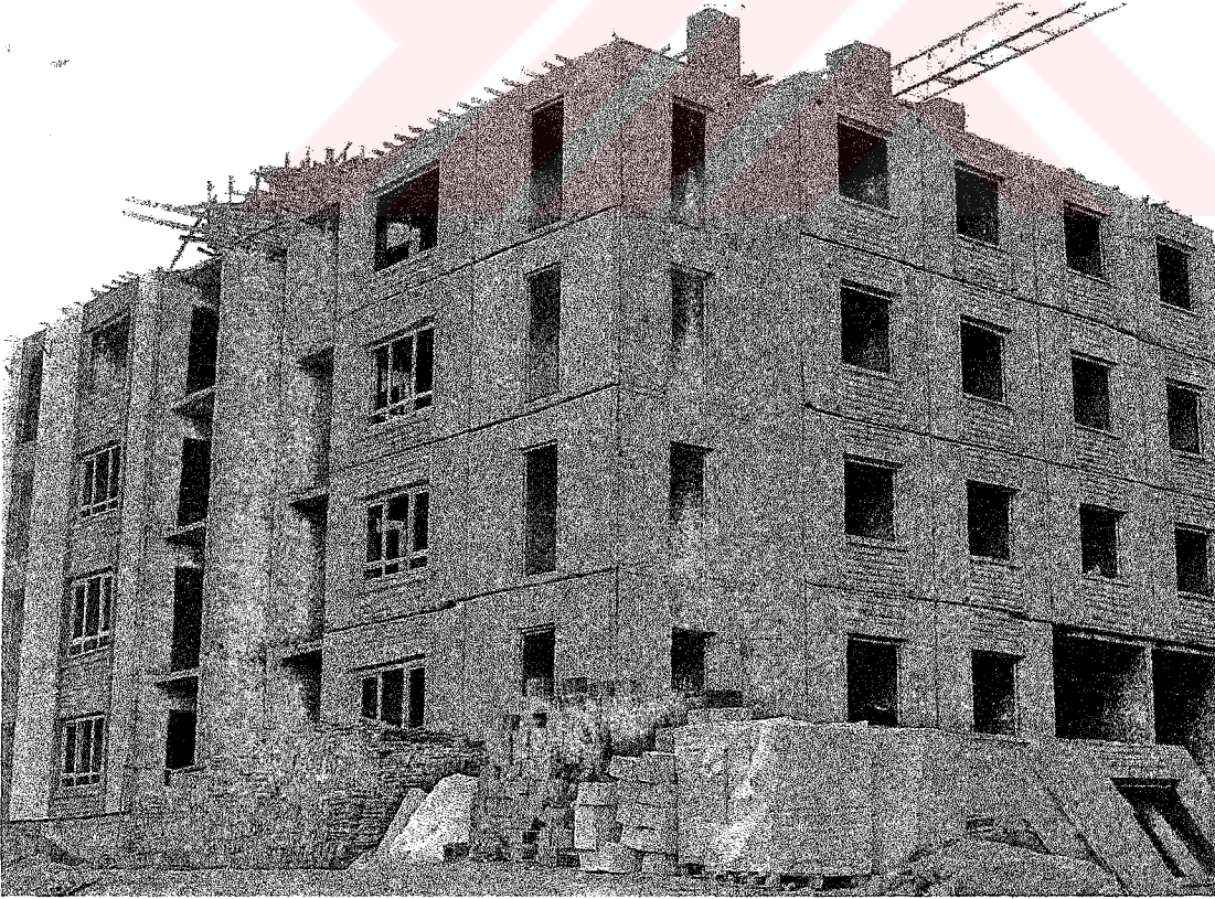
Şekil 5.22 Prekast asımları bitmiş bir binanın görünüşü
