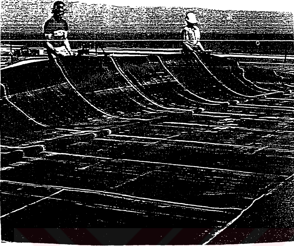
Şekil 3.30 Tek parça halinde uygulanan plastik örtünün serilmesi
