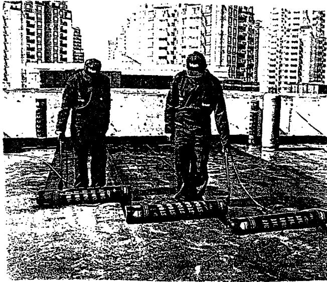
Şekil 3.26 Plastomerik polimer bitümlü su geçirimsiz örtülerin şalımo alevi ile ısıtılarak yapıştırılması
