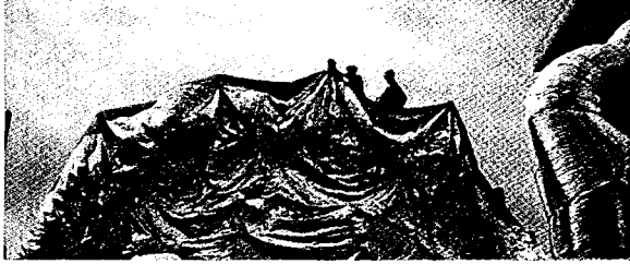
Şekil 4.116 Duvarın şişirilme işleminden bir görünüş (Architectural Review,2000; s:46).
