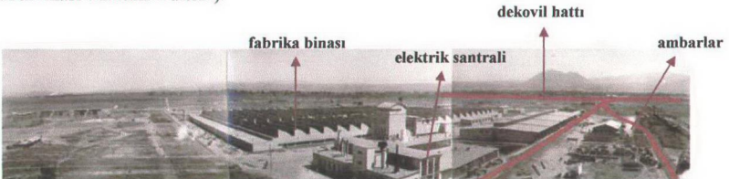
Şekil 5.29 Demiryolu bağlantısı ile beraber fabrikanın genel görünümü, (Fabrika arşivi)
