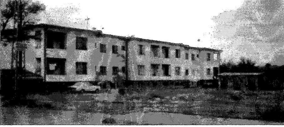
Şekil 5.46 Dış usta apartmanları görünüşü, (Özel çekim)
