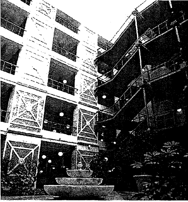
iç avlu görünüşü
