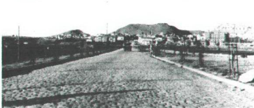
Şekil 3.32 Ankara İstasyon Caddesi ve cadde üzerinde gelişen yapılar ve yaşantı 1920-1940 arası.
