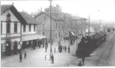
Ankara eski istasyonu peron cephesi
