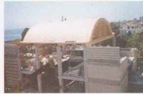
Şekil Ek 1.14 Çatı kaplama aşaması[36]
