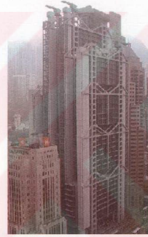
Şekil 3.16 Hongkong Shanghai Bankası (Şantiye aşaması) [22]
