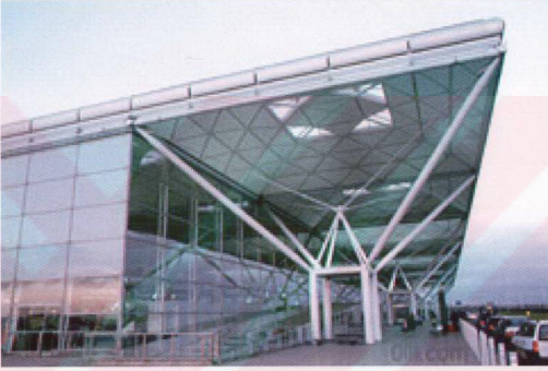
Şekil 5.1 Stansted Havalimanı çelik bağlantıları, İngiltere, Mimar Norman Foster [29]
