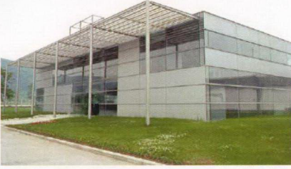
Şekil Ek 1.11 Giriş cephesi bakış[35]
