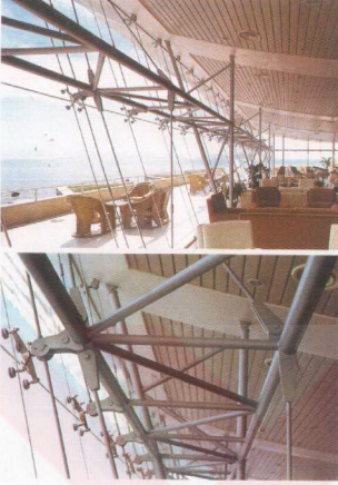
Şekil Ek 1.18 İç mekandan strüktüre bakış ve spider detayı (Anon,2000, 40-43)
