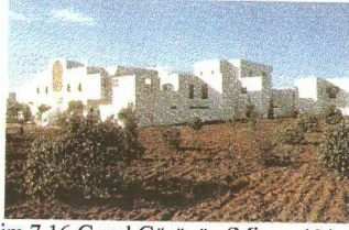
Resim 7.16 Genel Görünüş (Mimar 13/ sf 20)
