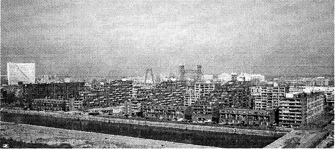
Resim 3.7 Proje dahilinde inşa edilen yapılar.
