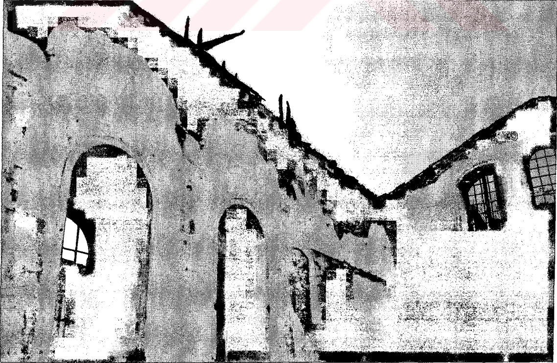
Resim 5.14 Küçük Kilise çatı konstrüksiyonu izleri
