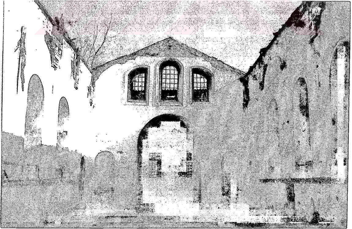
Resim 5. 27 Küçük Kilise apsid duvarı
