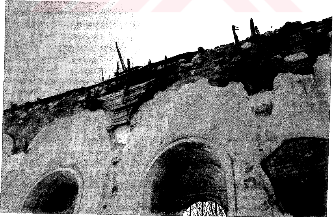
Resim 5.31 Kemerlerde bağdadi çitası
