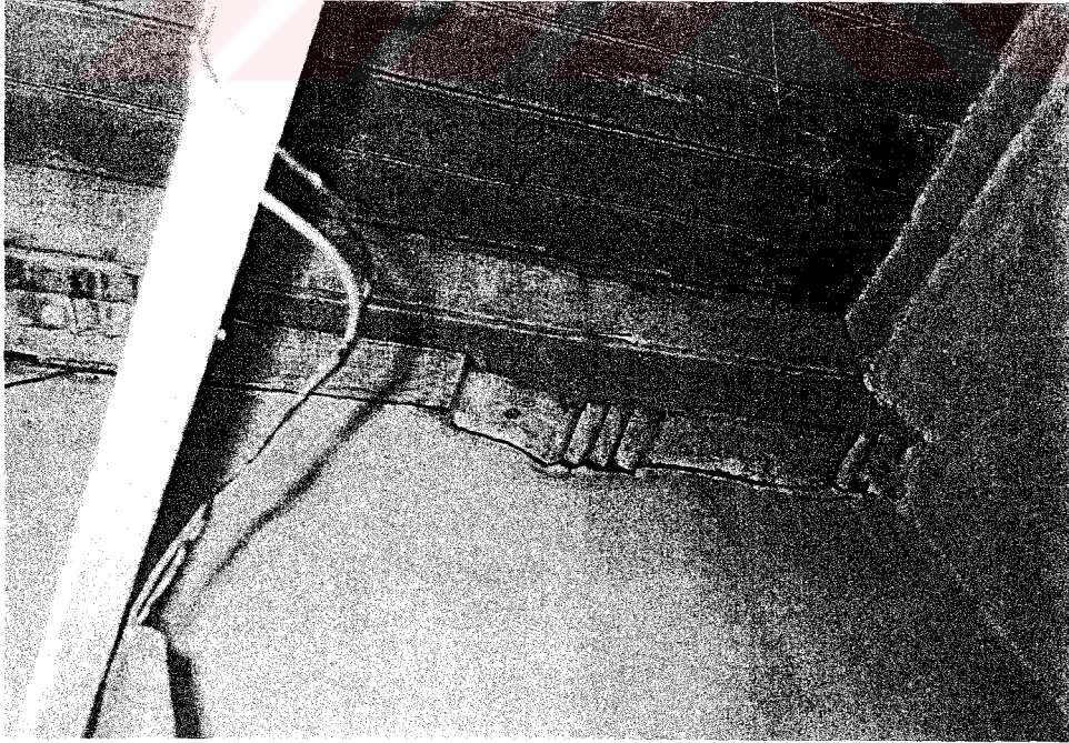
Fotoğraf 3.61 Kadı Ahmet Efendi evi IO 7'ni ahşap çatı destek elemanı
