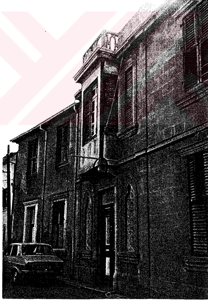
Fotoğraf 3.42 Cumbalı 23 no.lı evin giriş cephesi.
