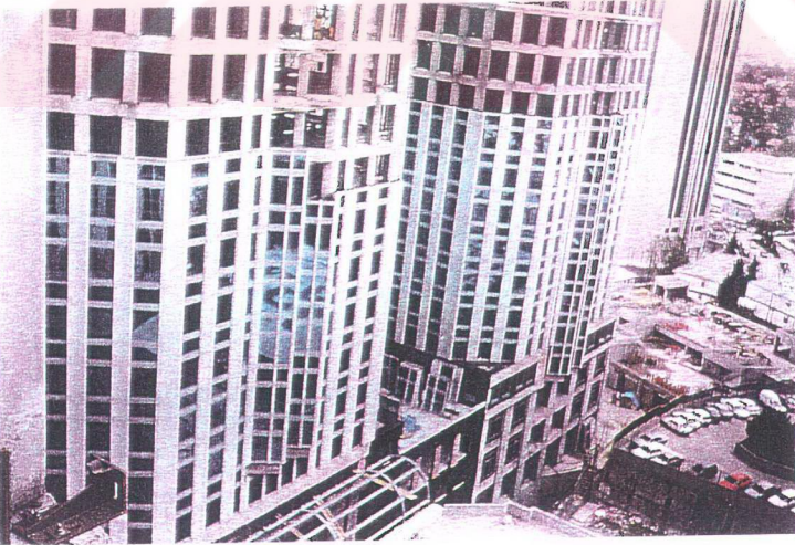
Şekil 2.16 Panel sistem ile yapılan İş Bankası Genel Müdürlük Binası
