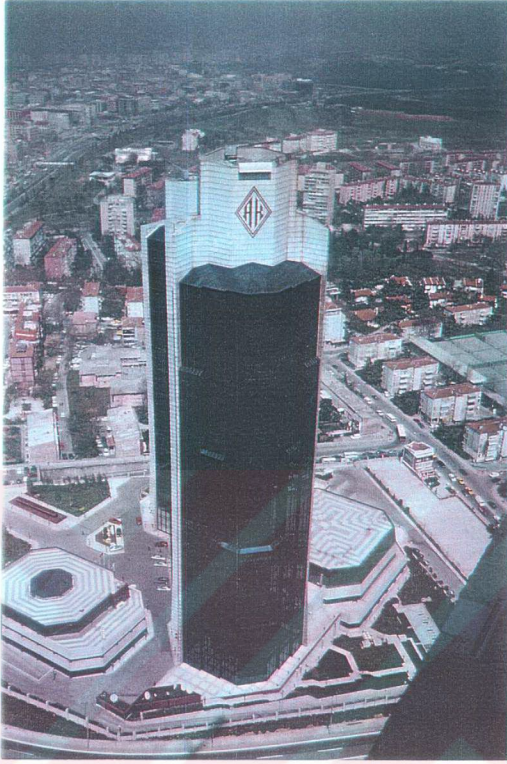
Şekil 2.13 Yarı panel sistem ile yapılmış olan Sabancı Center Binası
