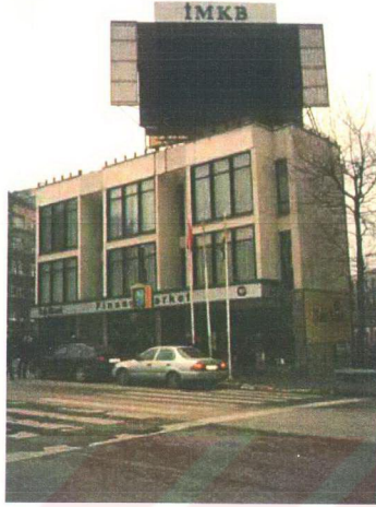
Şekil 4.3 Sonradan yapılan “ek”in yapı yüzeyiyle olan oransızlığı, Taksim, 2002
