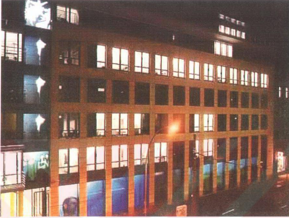
Şekil 3.79 VEAG Ofis Binası
