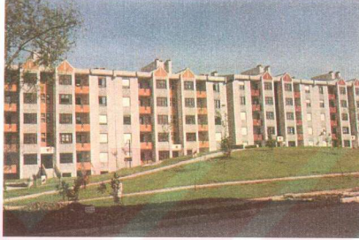
Şekil 3.3 Emlak Bankası: Ataköy 7. 8. Mahallesi
