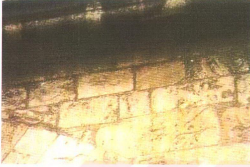
Şekil 3.21 Caminin doğu cephesi üzerinde yer alan taşçı işaretleri
