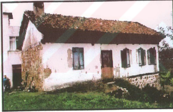
Şekil 4.46 Özgen mahallesine ait köy evi arka cephesi
