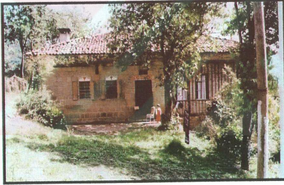
Şekil 4.38 Pervane köyü evi ön cephesi
