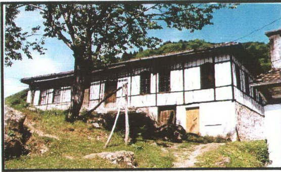
Şekil 4.34 Merkezköy evi arka cephesi
