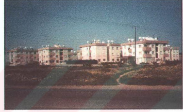
Şekil 5.32 Dış mekan düzenlemesi yok.
