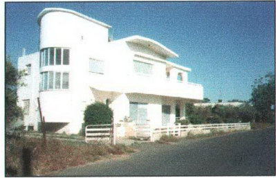
Şekil 4.17 Kıbrıs Modern Mimarisine ait iki katlı bir konut örneği.
