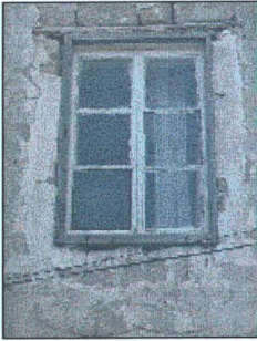
Şekil 5.20 Camı küçültülmüş Osmanlı dönemine ait ahşap pencere.
