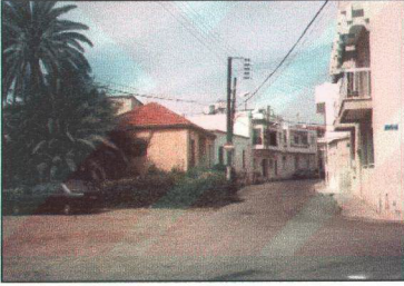
Şekil 4.18 Sur-içi'ndeki tarihi dokuya aykırı yapılar.
