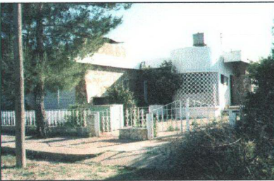
Şekil 4.16 Kıbrıs Modern Mimarisine ait tek katlı bir konut örneği.
