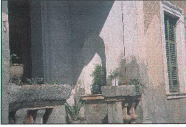
Şekil 5.31 Tek katlı eve ait kapı önü giriş terası.
