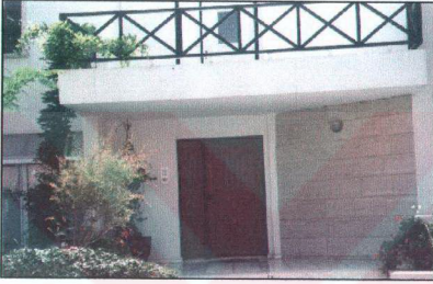
Şekil 5.74 Evin giriş kapısı.
