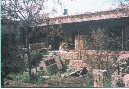
Şekil 5.4 İç avludan görünüş.
