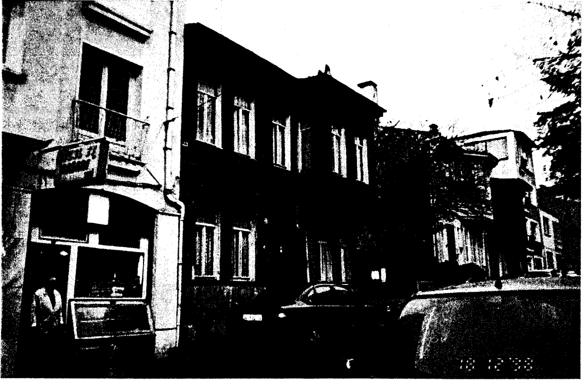
Resim 3.47 Muvakkithane cad. 99 ada-13 parsel
