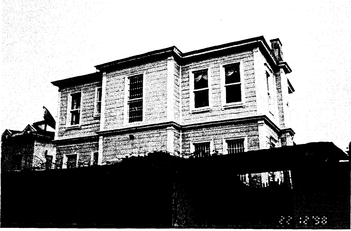
Resim 3.85 Koru Yolu sk. 94 ada-12 parsel
