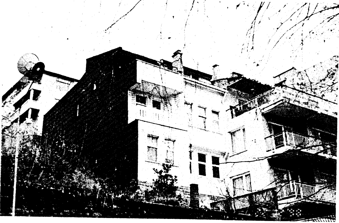
Resim 3.59 Mektep sk. 100 ada-18 parsel
