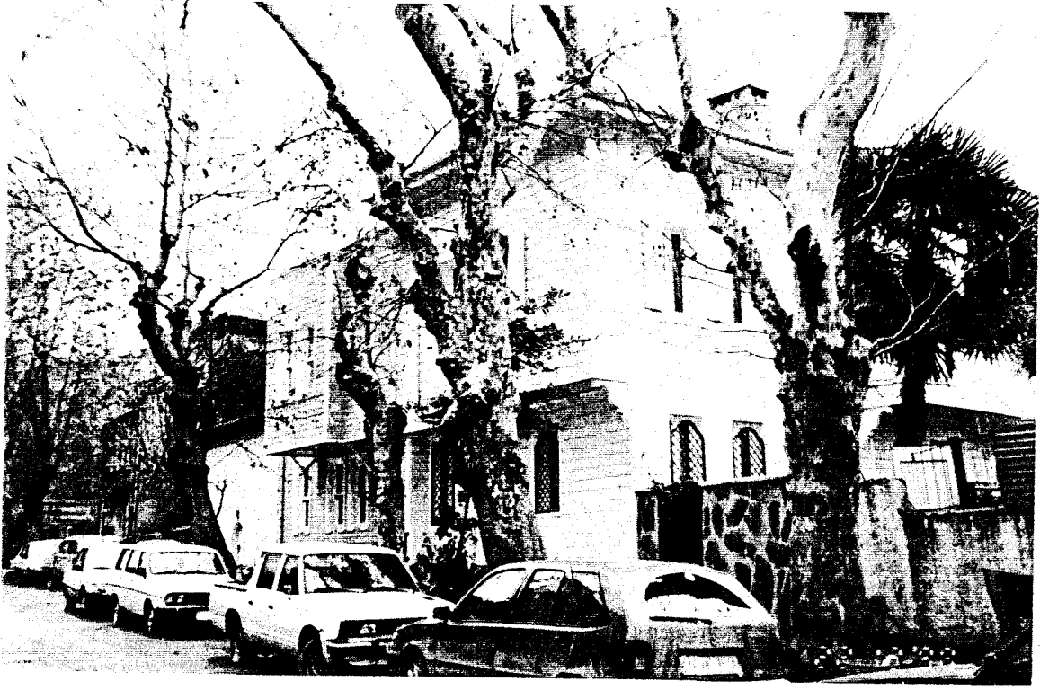
Resim 3.57 Mektep sk. 99 ada-22, 23, 24 parsel
