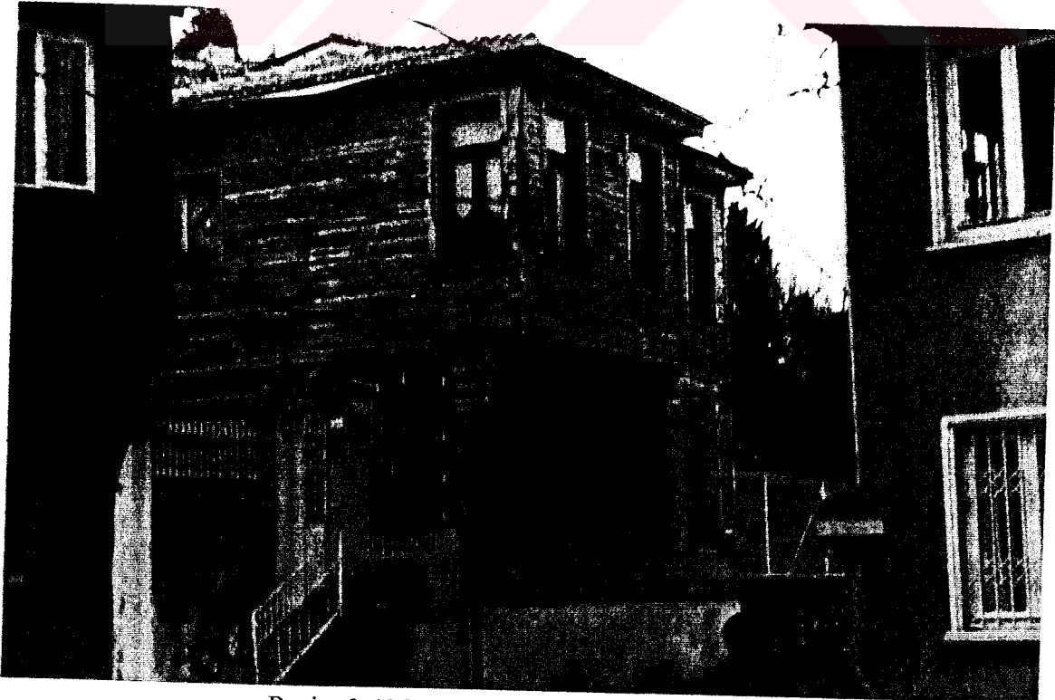
Resim 3.42 Muvakkithane cad. 130 ada-12 parsel
