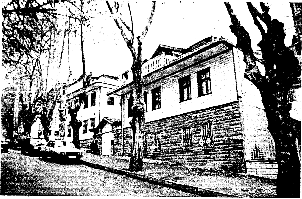
Resim 3.53 Mektep sk. 99 ada-2 parsel
