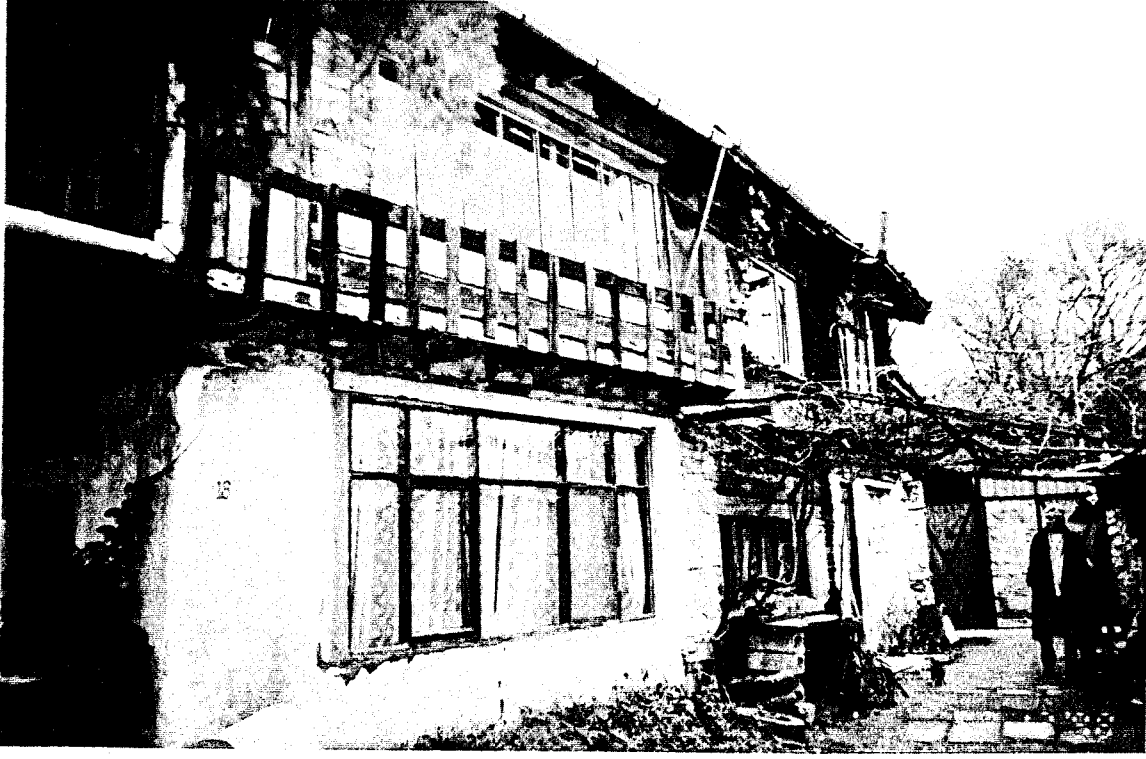
Resim 3.87 Koru Yolu sk. 94 ada-1 parsel
