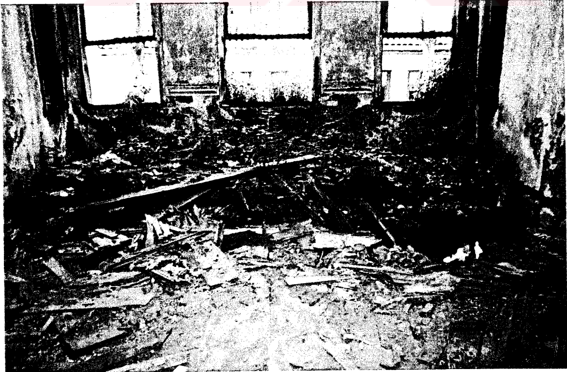
Resim 4.25 2.02 Mekanın kırılmış döşemesi
