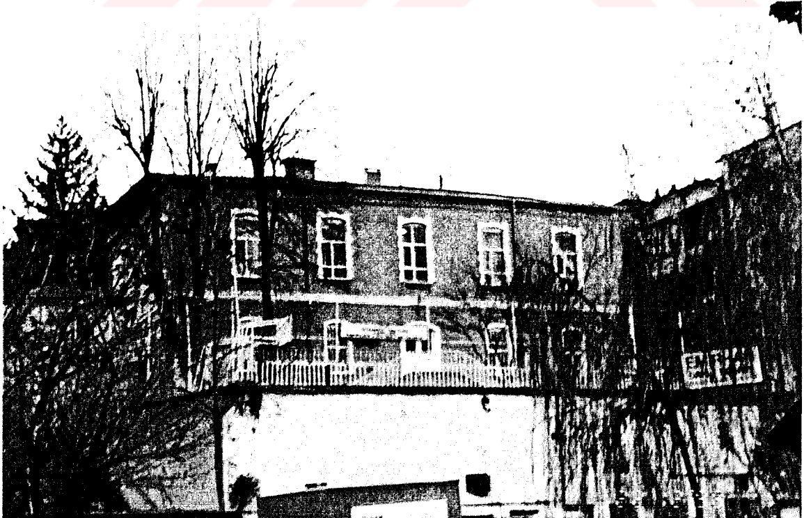
Resim 3.58 Mektep sk. 100 ada-21 parselde yer alan Emirgan İlköğretim Okulu
