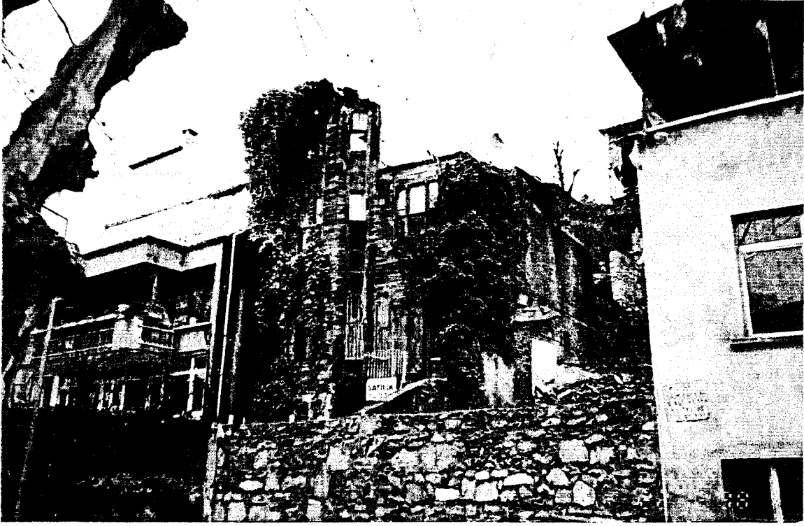
Resim 3.61 Mektep sk. 100 ada-12 parsel
