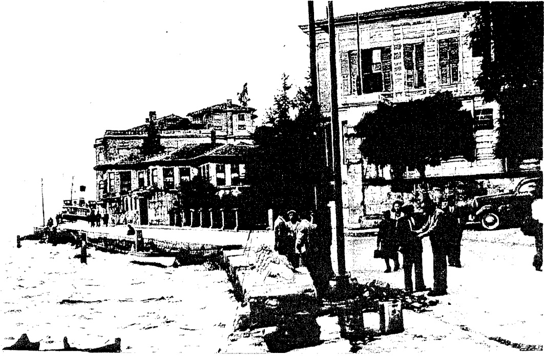
Resim 3.26 Harem binası yıktırılmadan önce Şerifler Yalısı ve Emirgan Cami (Erdenen, 1994)
