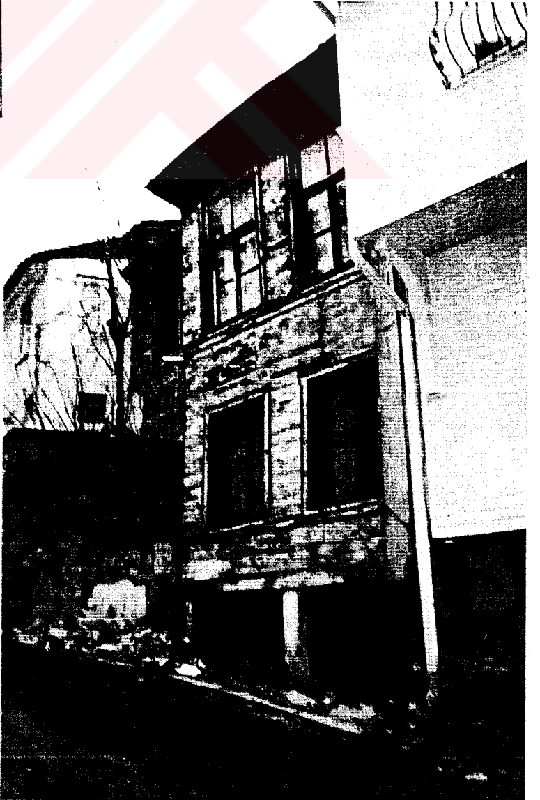
Resim 3.71 Emirgan Çeşmesi sk. 92 ada-37 parsel
