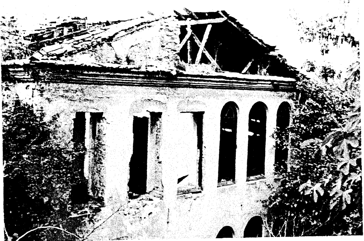
Resim 4.11 Arka cephe 3. kat ve çatı görünüşü
