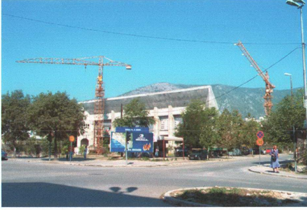
Resim 5.6 Hırvat bölgesinde inşaat halindeki stadyum yapısı
