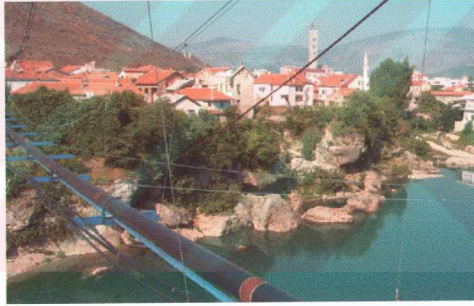
Resim 3.6 Hırvatlar'dan Boşnak bölgesine boru hattı ile su taşınması
