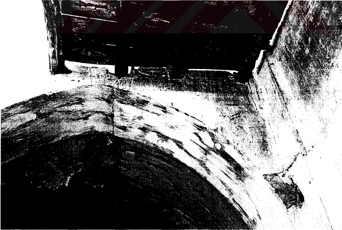
Resim 5.9 Parekklesion tavanındaki çatlak
