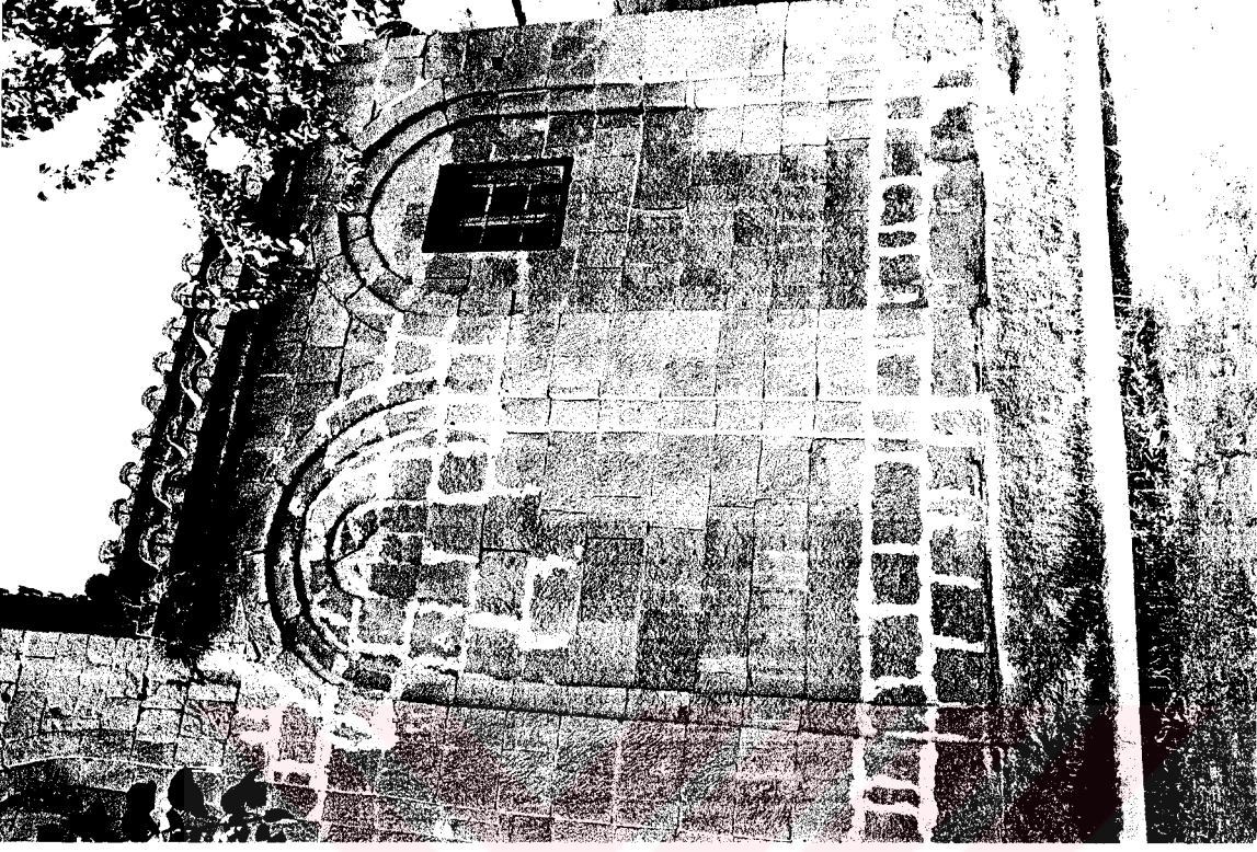
Resim 5.7 Güney cephesinde kireç harçıyla derzleme
