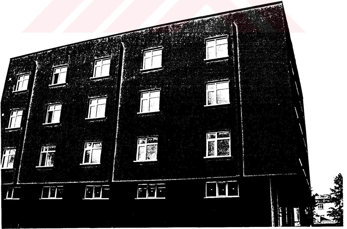
Resim E.2. Yapı 1.2., dıştan görünüşü.
