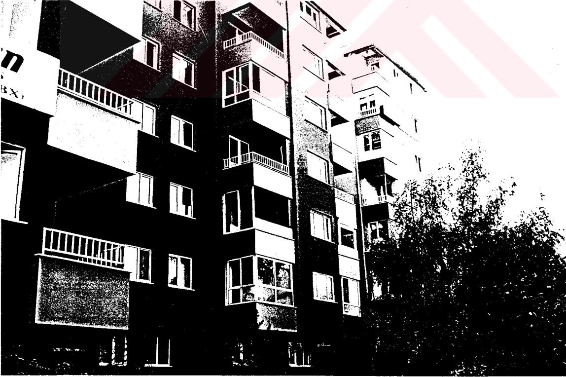
Resim E.15. Yapı 2.3. dıştan görünüş.
