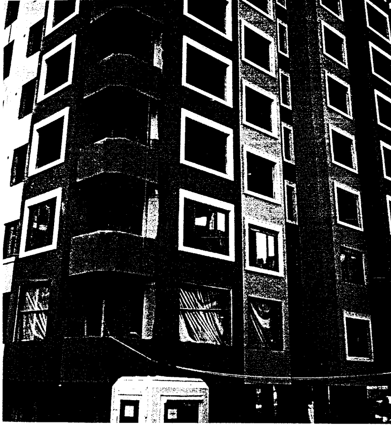
Resim E.11. Yapı 1.11, dıştan görünüş.
