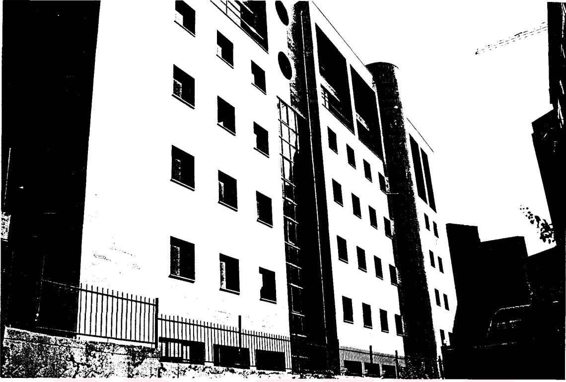
Resim E.22. Yapı 3.5., dıştan görünüş.
