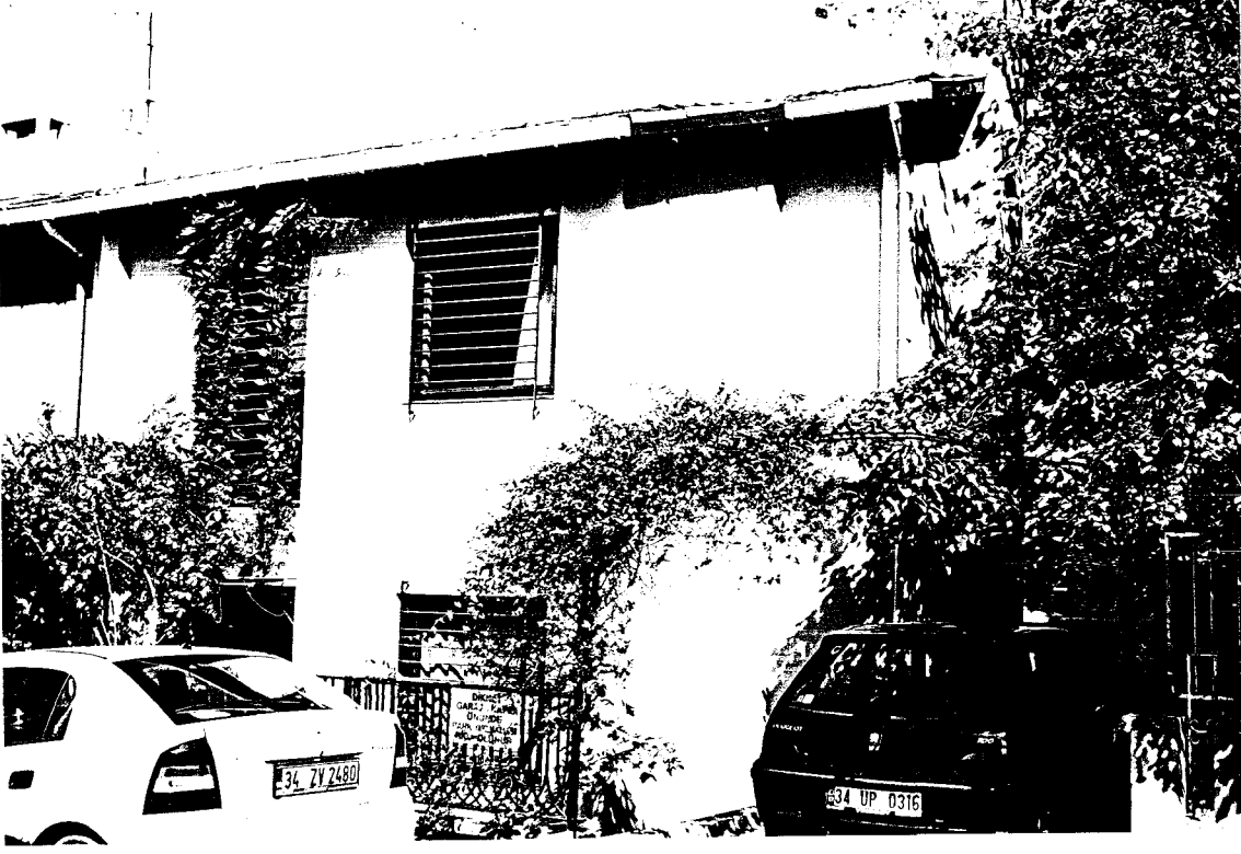
Resim E.9. Yapı 1.9, dıştan görünüş.
