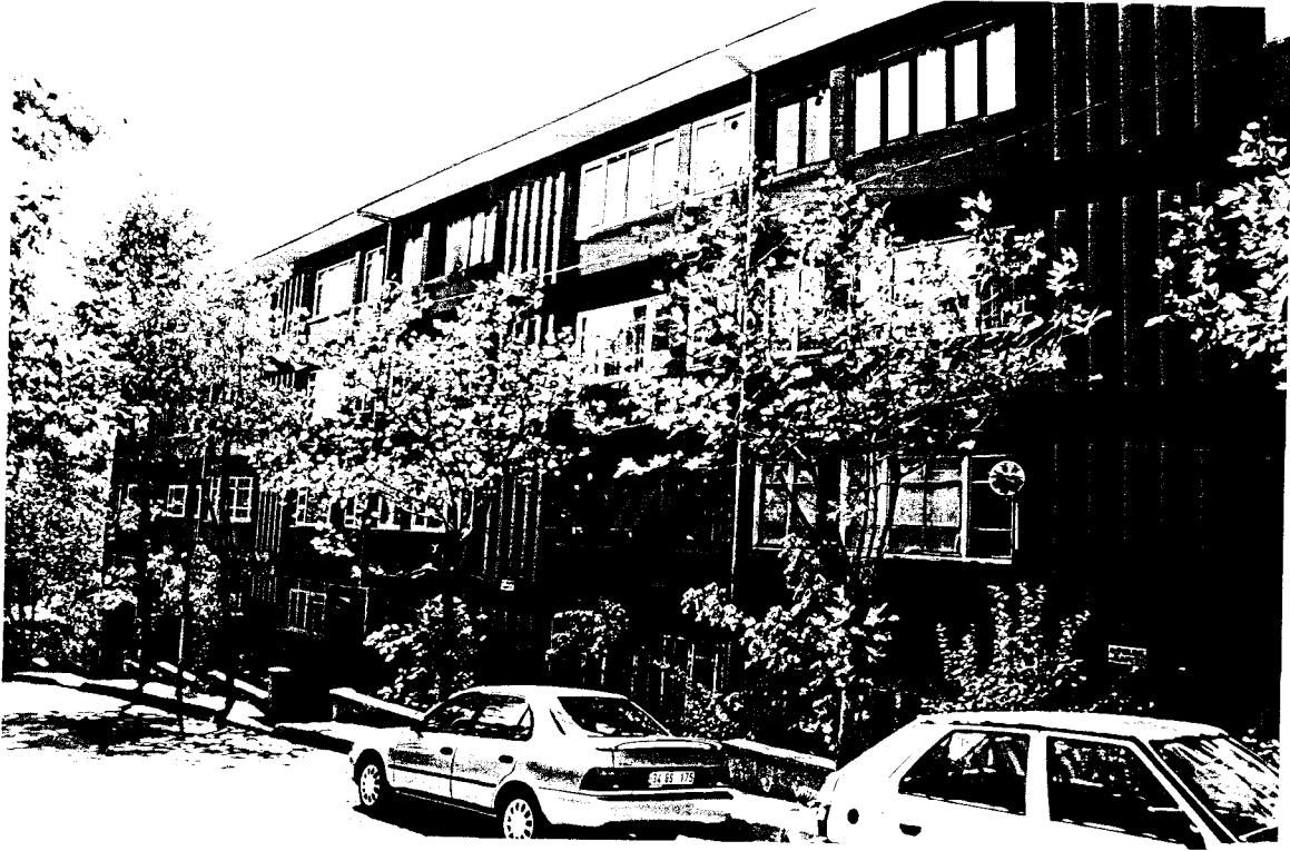
Resim E.16. Yapı 2.4., dıştan görünüş.
