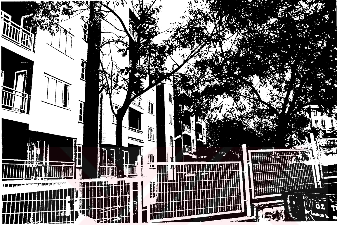
Resim E.21. Yapı 3.4., dıştan görünüş.
