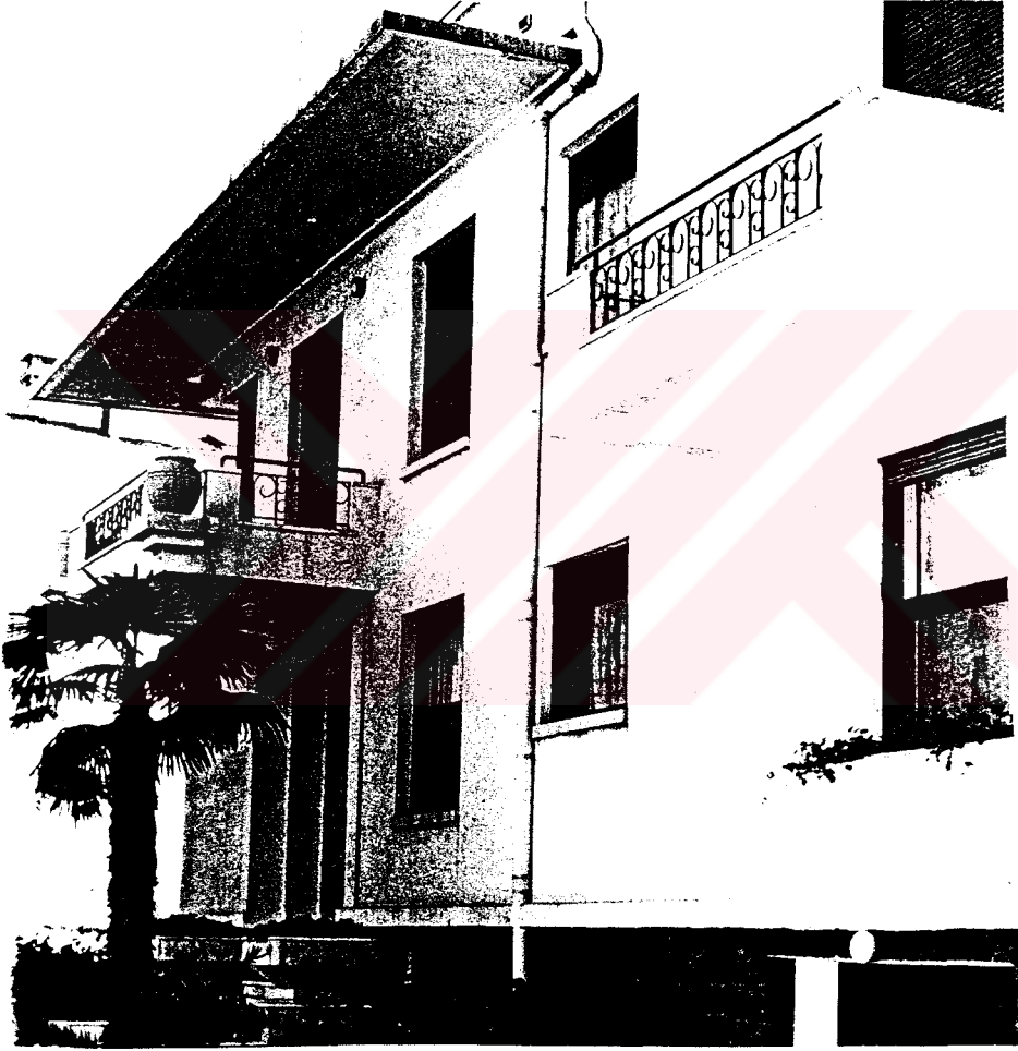
Resim E.19. Yapı 3.2., dıştan görünüş.
