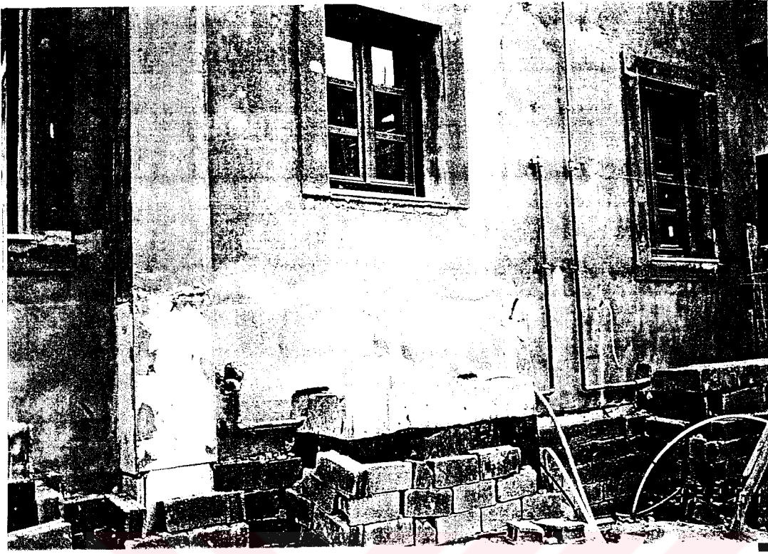
Resim E.8. Yapı 1.8, dıştan görünüş.
