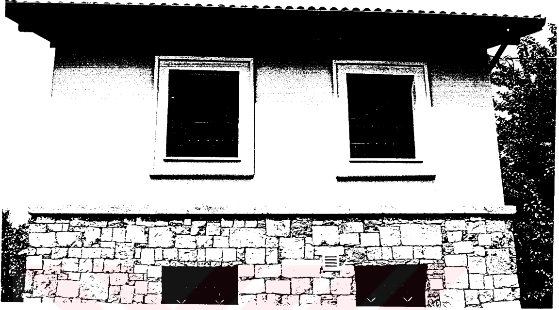
Resim E.4. Yapı 1.4, dıştan görünüş
