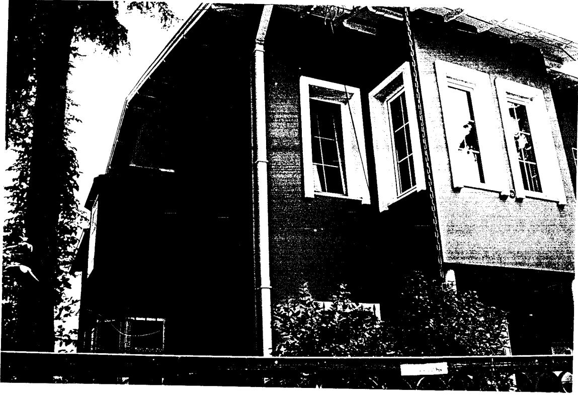
Resim E.6. Yapı 1.6, dıştan görünüş.
