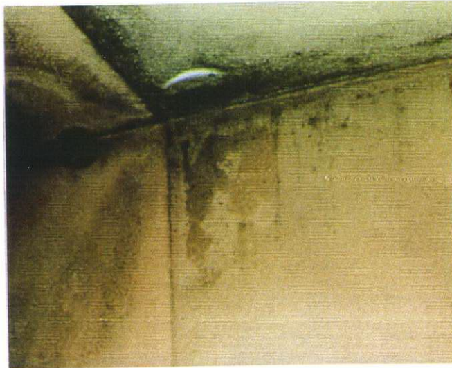
Resim 2.2. Yoğuşma oluşmuş duvar iç yüzeyi örneği. (Mardav, 2000)
