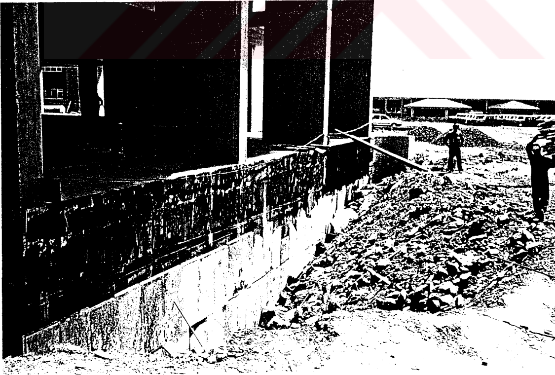
Resim E.12. Yapı 1.12, dıştan görünüş.
