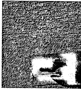
Resim 4.17. İnce sıva sonrası kaplayıcı uygulaması. (Ode, 2000)
