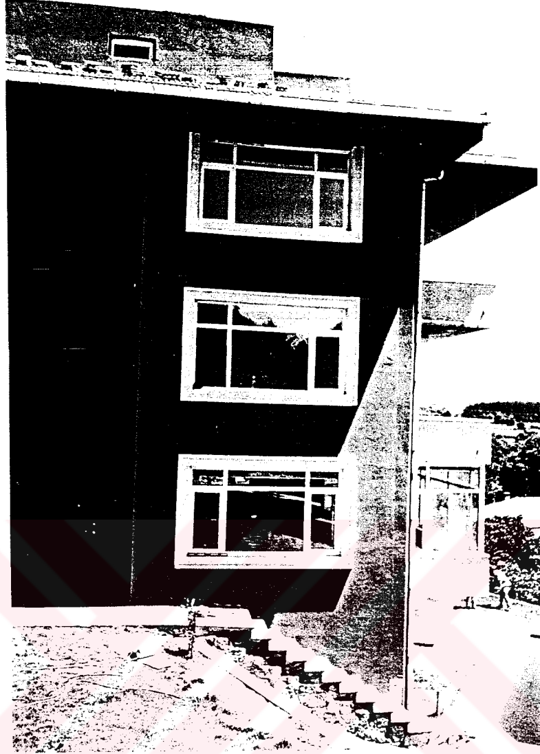
Resim E.3. Yapı 1.3, dıştan görünüş.
