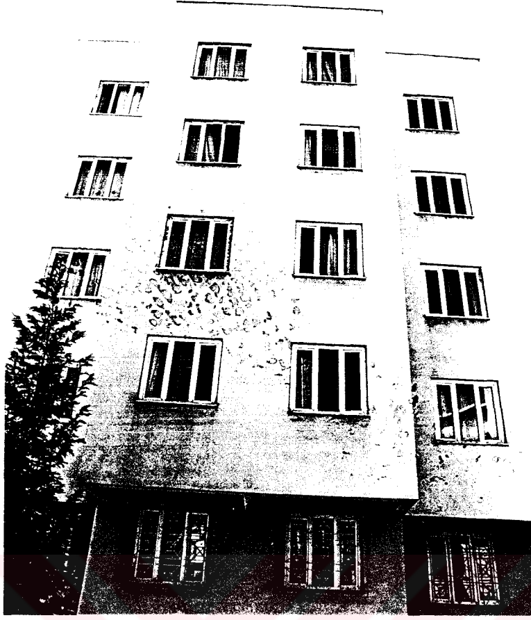
Resim E.17. Yapı 2.5., dıştan görünüş.
