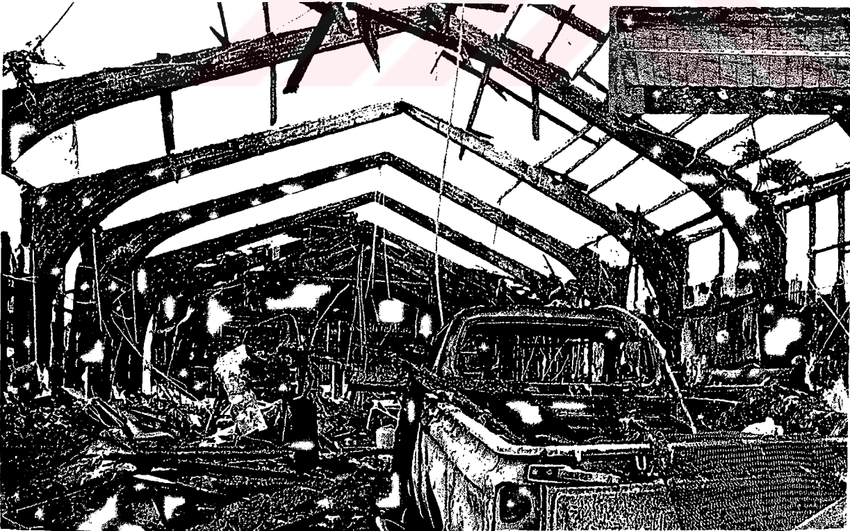
Şekil 4.1 Ahşap ve çeliğin yangın karşısındaki davranışı
