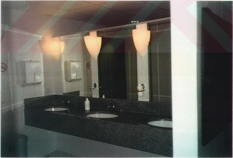
Şekil 4.9 – 4.10 İstanbul, Four Seasons Oteli, personel wc'den detaylar. Otelin müşteri wc'lerinde olduğu gibi gömme rezervuarlı asma klozet ve "Hilton tipi" mermer tezgahlı lavabolar kullanılmış.
