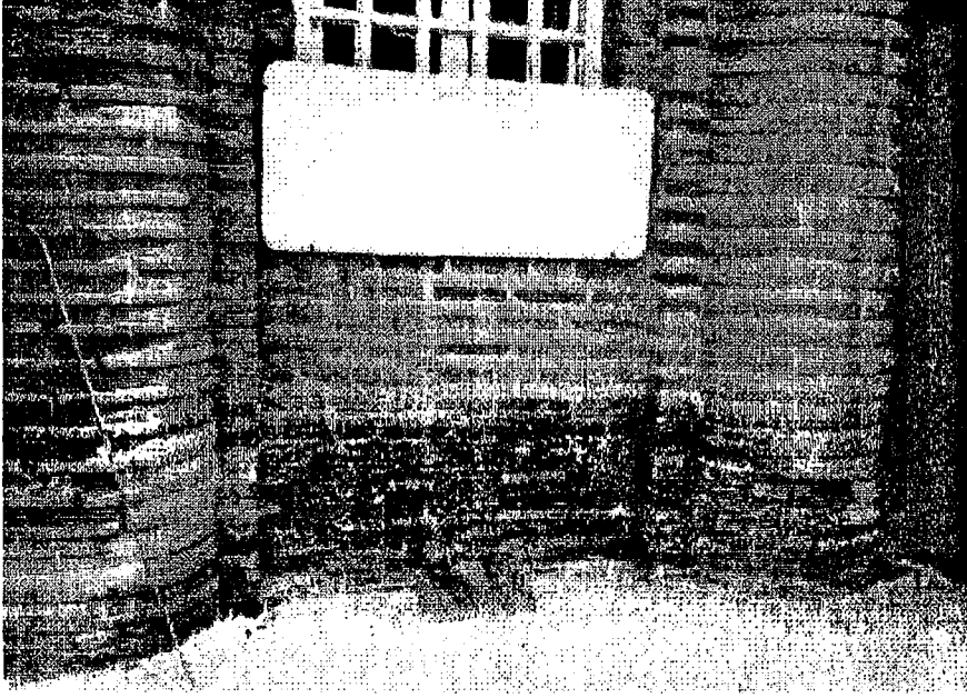
Resim 3.20 2A Duvarındaki Yosunlanma
