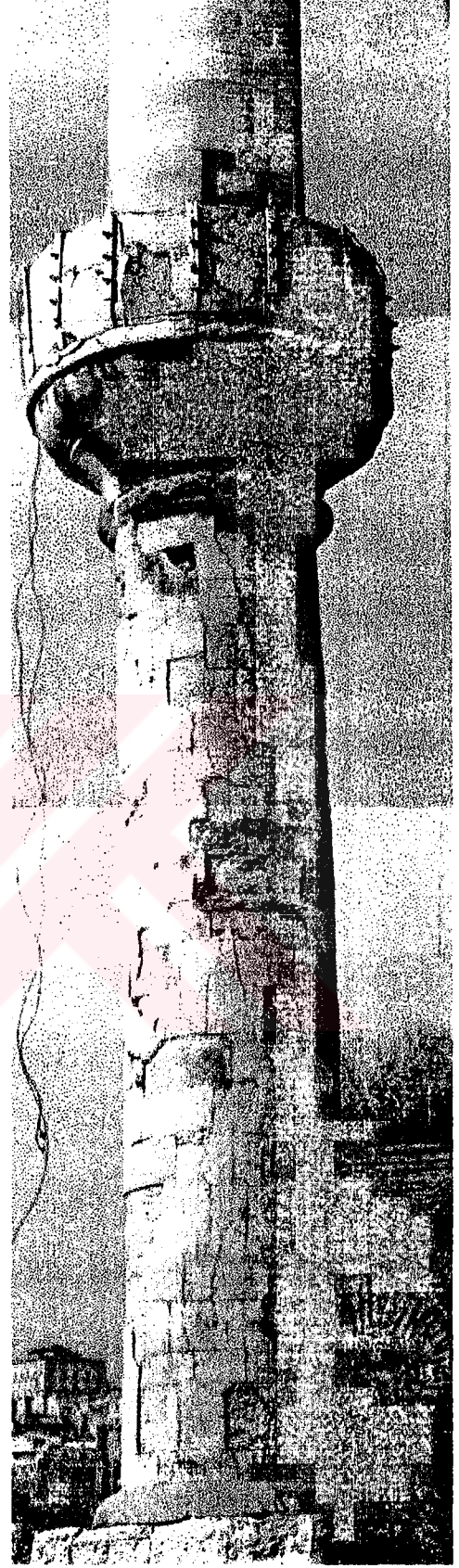
Resim3.11 Minarede Kum Taşında Bozulma
