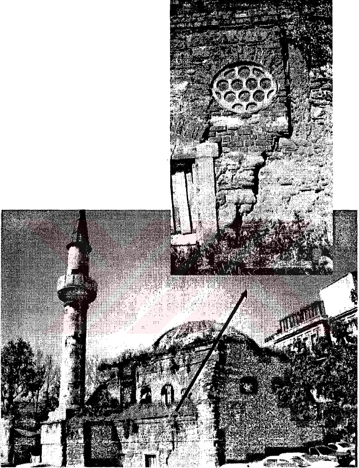
Resim 3.9 9C Duvarındaki Zemin Oturması Ve Hatalı Duvar Örgüsünden Kaynaklanan Çatlak
