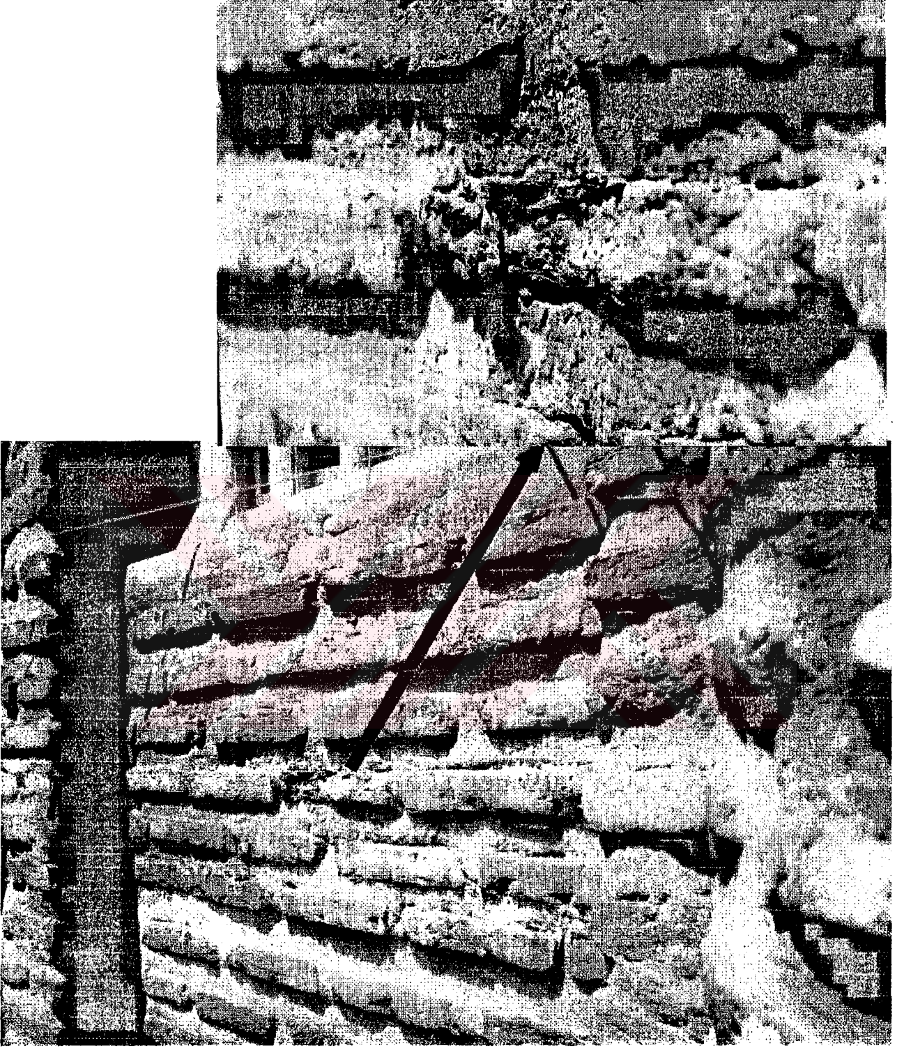
Resim 3.22 7A Duvarında Tuğlada Su ve Don Etkisi Bozulma
