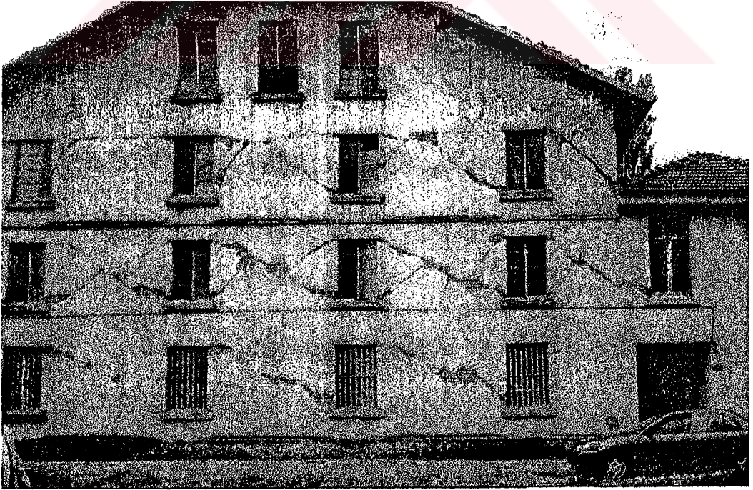
Resim2.8 İki Yönlü Deprem Etkisinde Yapı
