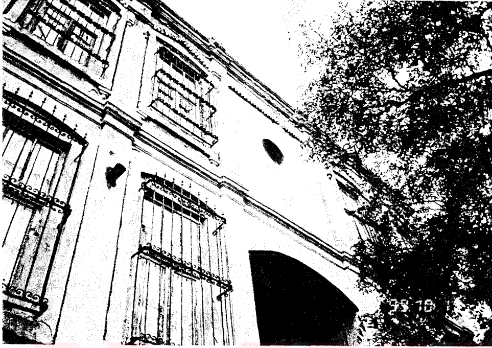
Fotoğraf ek 46: Güney cephesi (yan cephe)
