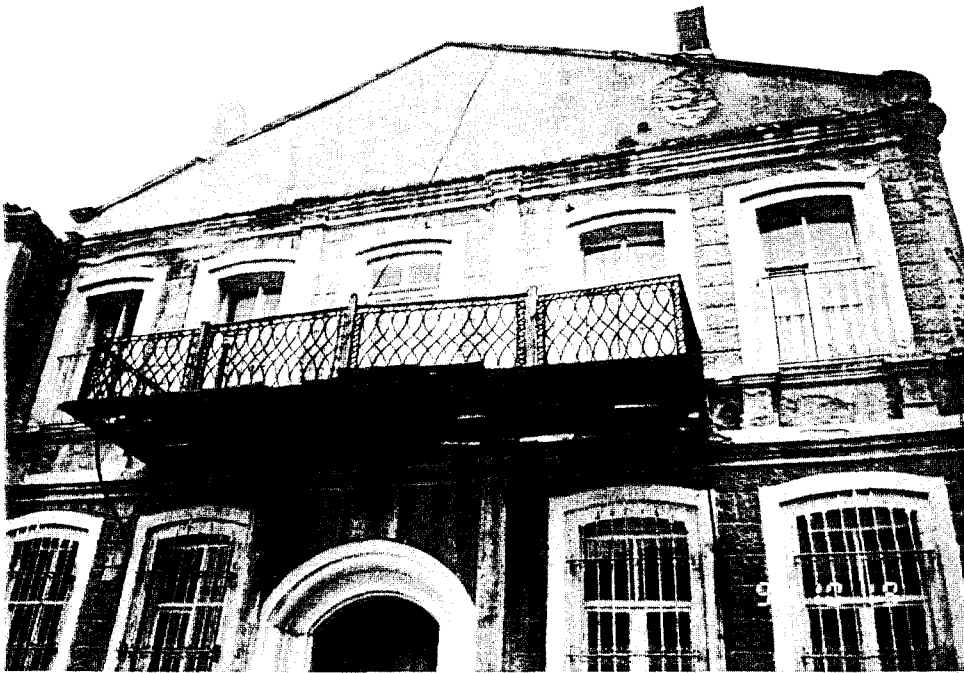
Fotoğraf 5.33 E.N:8 Balkon korkuluđu
