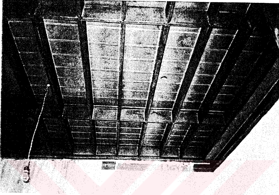
Fotoğraf ek 14: E.N:9 iç mekan
