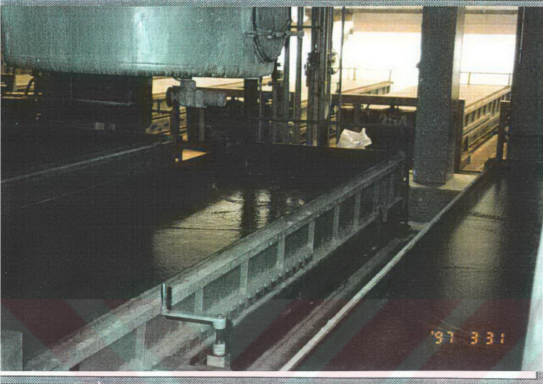
Çimentoş -Gazbeton Kırkkale Tesisi
