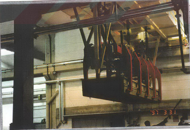
Çimentoş -Gazbeton Kırkkale Tesisi
