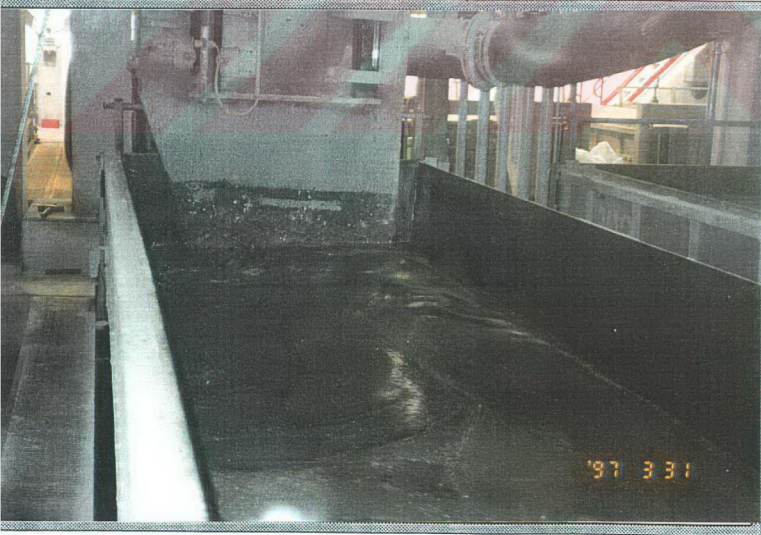
Çimentoş -Gazbeton Kırkkale Tesisi
