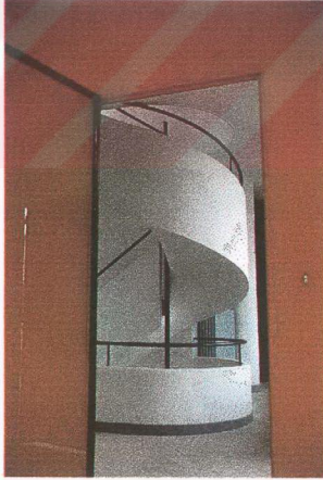
Şekil 3.3b Villa Savoye, betonarme merdivenler
