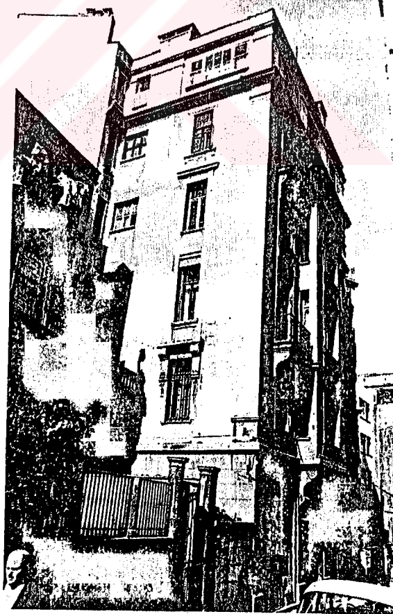
Resim 3.26 Üçüncü Vakıf Han giriş cephesi (Yavuz, 1981,s.171).
