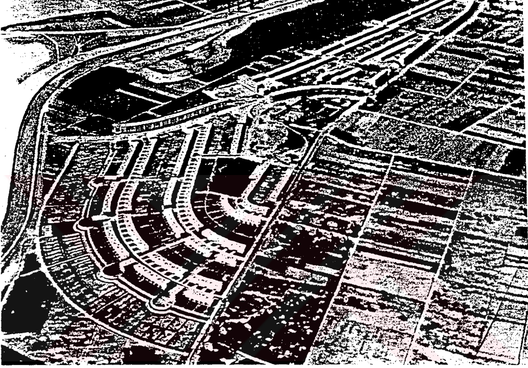
Şekil 3.24. Nidda Nehri projesinin temel yerleşimini oluşturan Römerstadt'ın hava görüntüsü.
