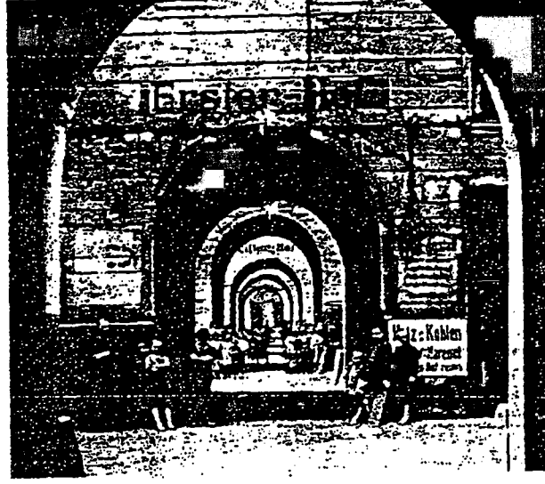
Şekil 1.2a “Meyers Hof” kira kışlasının avlular arasındaki geçiş kapıları
