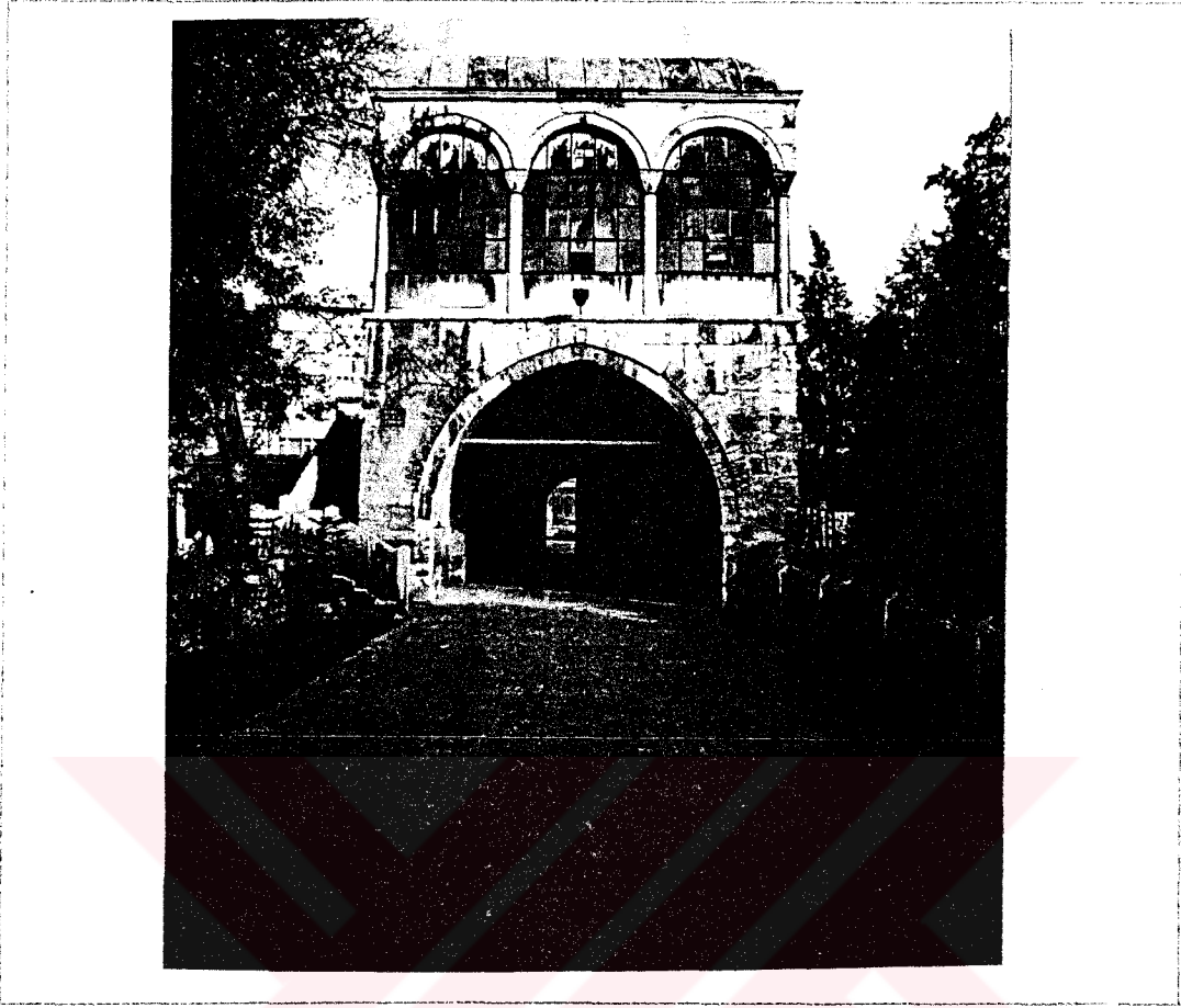
Resim 3.30. Hekimoğlu Ali Paşa Kütüphanesi'nin Bahçeden Görünüşü (1995)
