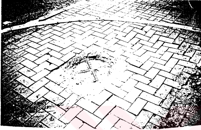
Şekil 4.14 Yanlış uygulanan bitiş ürünleri
