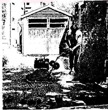
Şekil 4.27a Taban tuğlası uygulaması için zeminin hazırlanması
