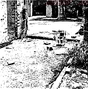
Şekil 4.27a Taban tuğlası uygulaması için zeminin hazırlanması
