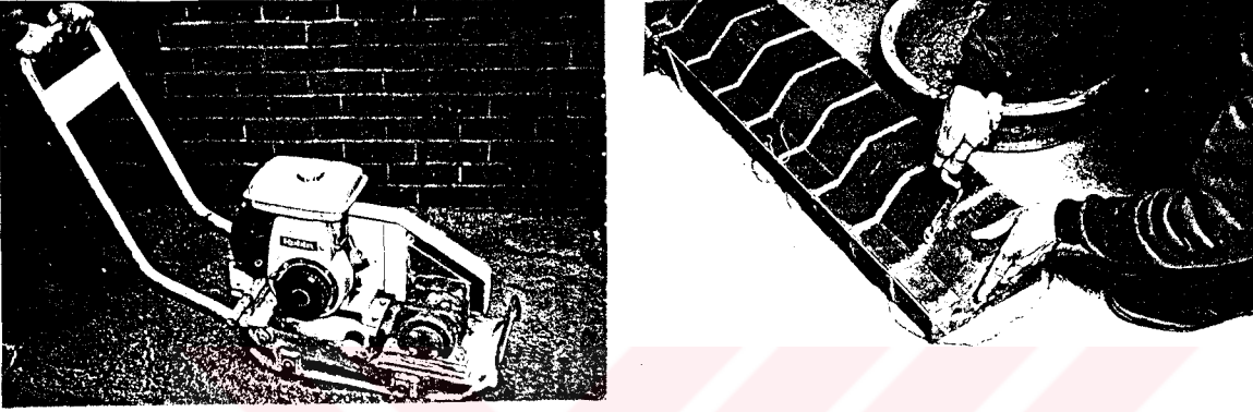
Şekil 4.17 Kompaktör ve derz malası kullanımı
