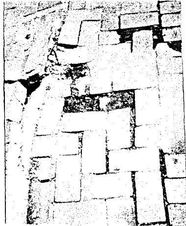
Şekil 4.12 Tuğla örümünde oluşan çözümler
