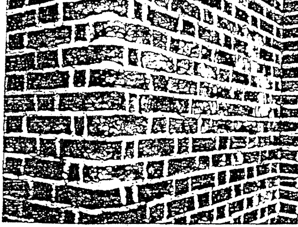
Şekil 4.9 Derzlerde sülfat etkisi
