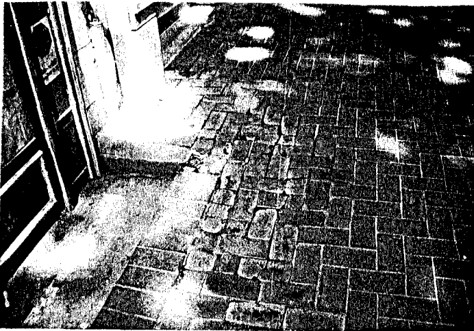
Şekil 4.10 Tuğla uygulamalarında zemin oturması (Tasman)
