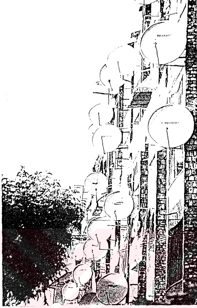
Şekil 3.30. Binalarda yeni cephe elemanları, uydu antenler (Anon, 1997e)
