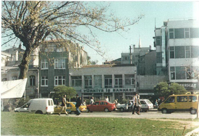
Resim 2.9. Yeni ve Eski Binaları ile Kadıköy
