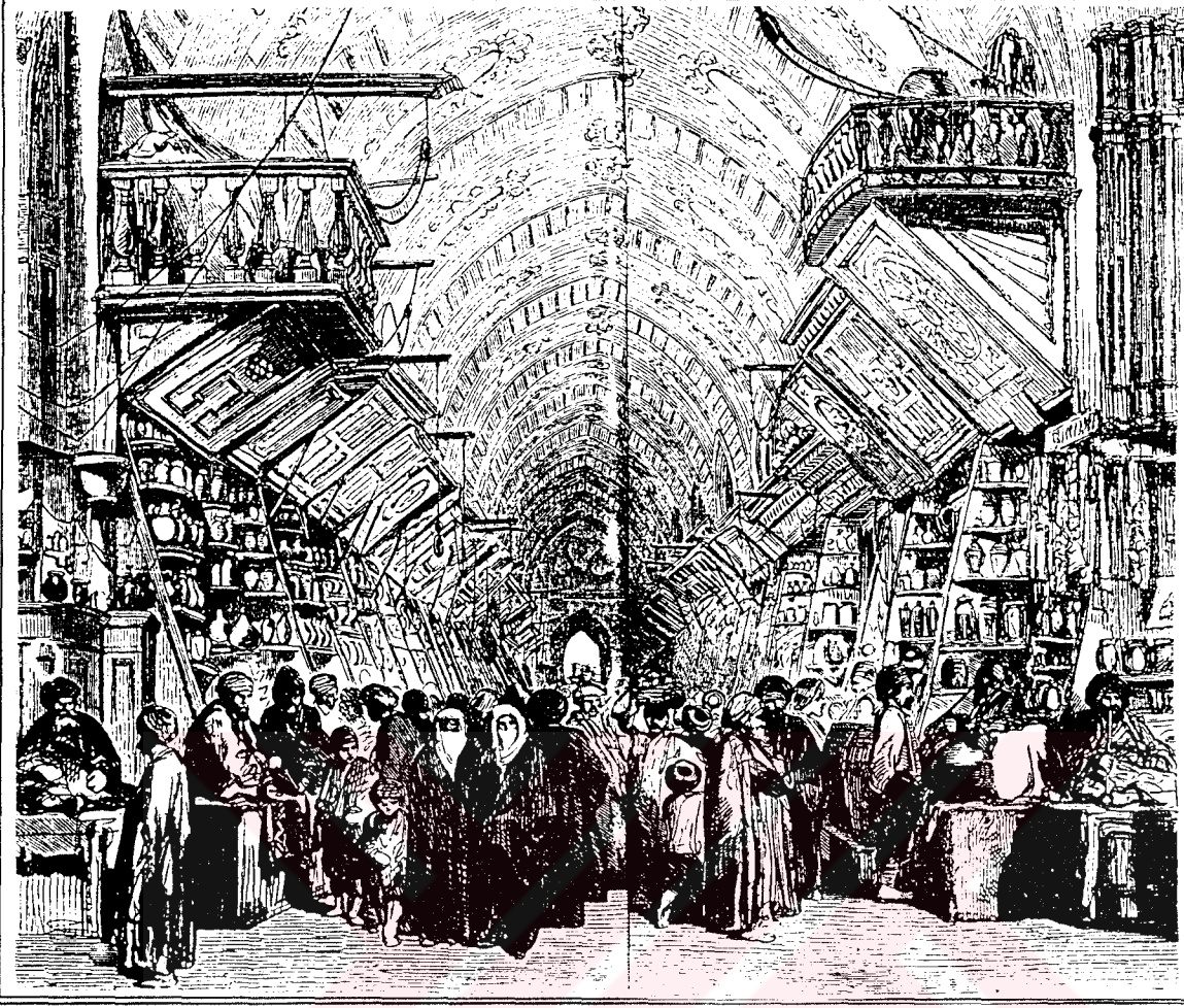
Şekil 5.5-10 Kapalı Çarşı iç mekan
