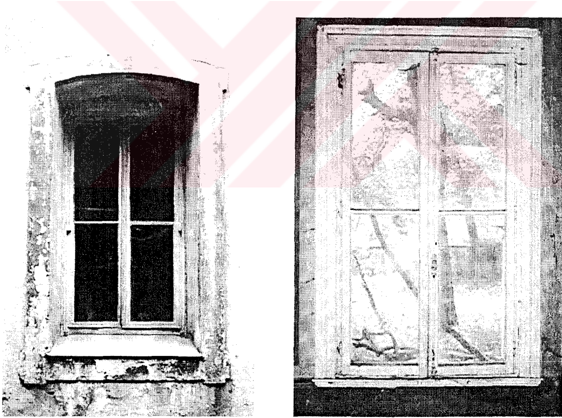
Fotograf 4.13. Basık kemerli pencere dışardan ve içerden görünüş.
