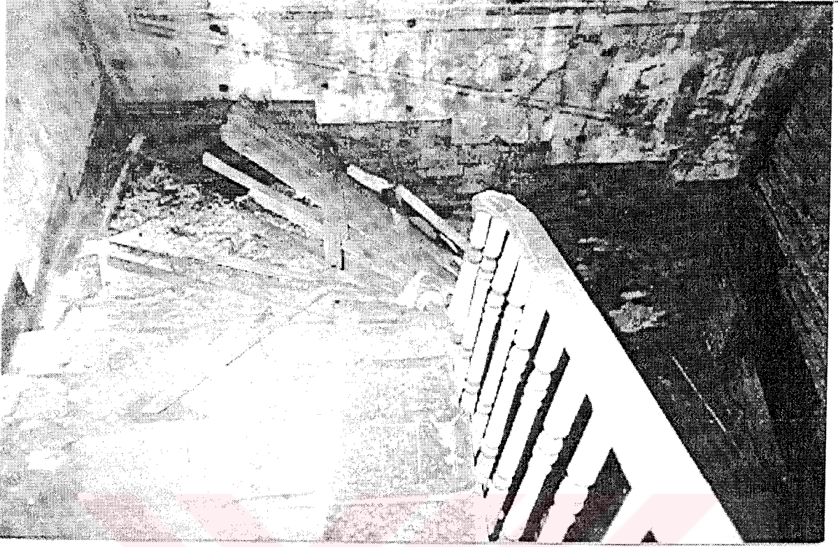
Fotograf 4.17. Merdivenden görünüş.
