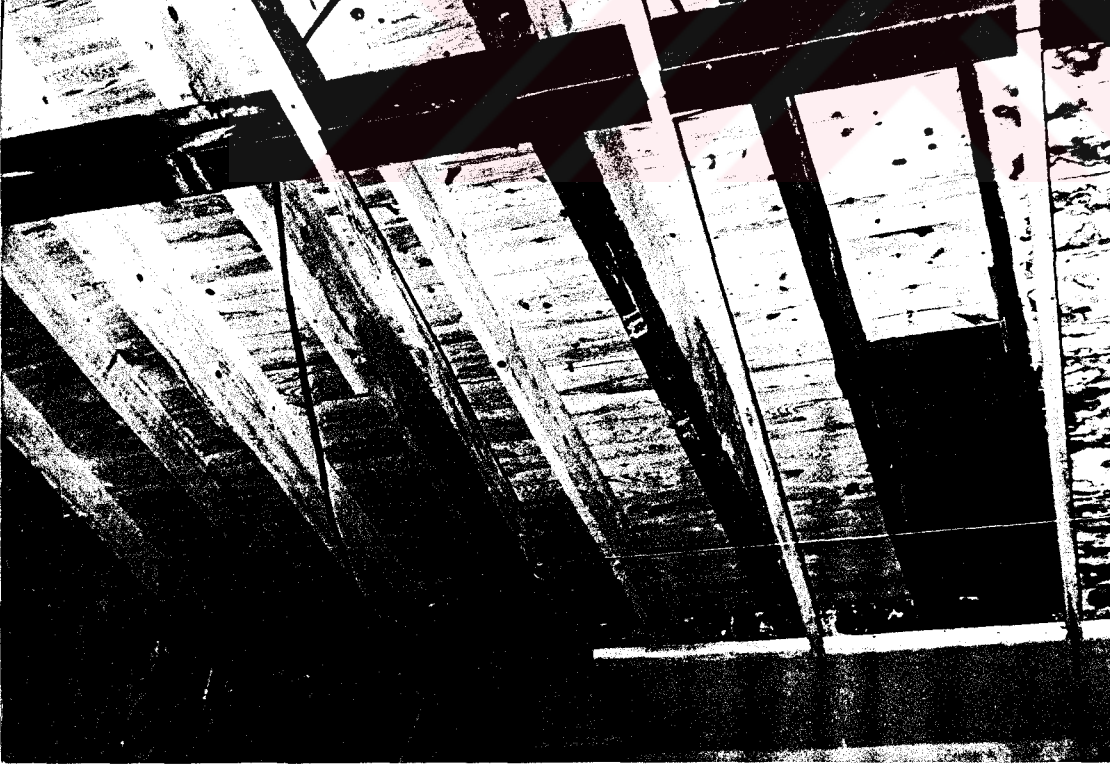
Resim 5. 32 Yangın sonrası yapılan onarım
