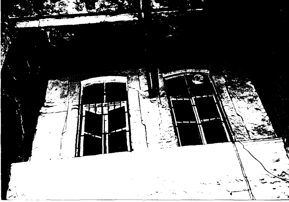
Resim 4. 37 A yapısı, I. bölüm kilise yönü cephesi
