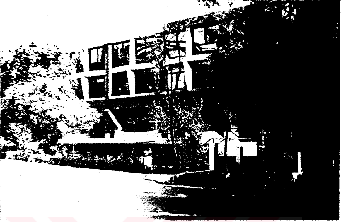
Fotoğraf 26 : Altunizade Külliye yapılarının tam karşısında Koşuyolu Caddesi üzerinde yeni bitmiş bir yapı.
