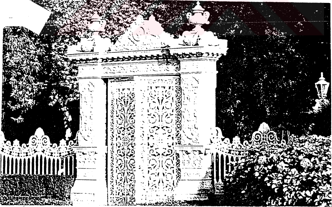
Resim 63- Küçüksu Kasrı Dökme demir kapı
