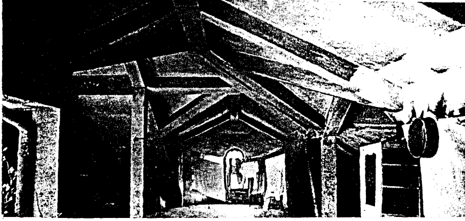
Şekil 3.146 Tayyare Apartmanları Betarme çelik strüktürü gösteren Fotoğraf (Yavuz, Yıldırım s.275)
