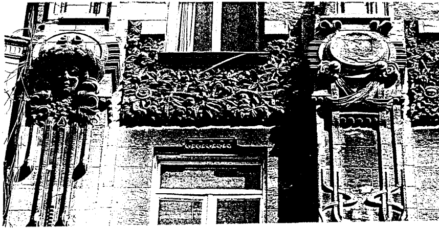
Şekil 3.112 Botter Apartmanı Cephe Süsleme Detayı
