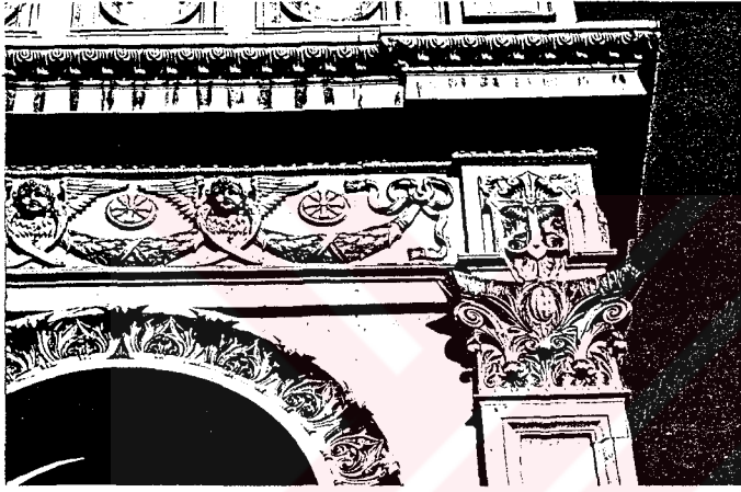
Cepheden ayrıntılar. Başlığıyla birlikte bir köşe pilastrı, pencere kemerini, üstünde askı çelenkli friz, saçak silmesi ve çatı parapetinin altı.
