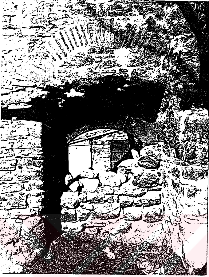
R . 29 Kapının iç mekandan görüntüsü
