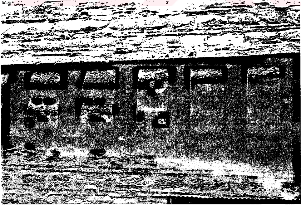
Resim 73- Konsollarda Kabuklaşma
