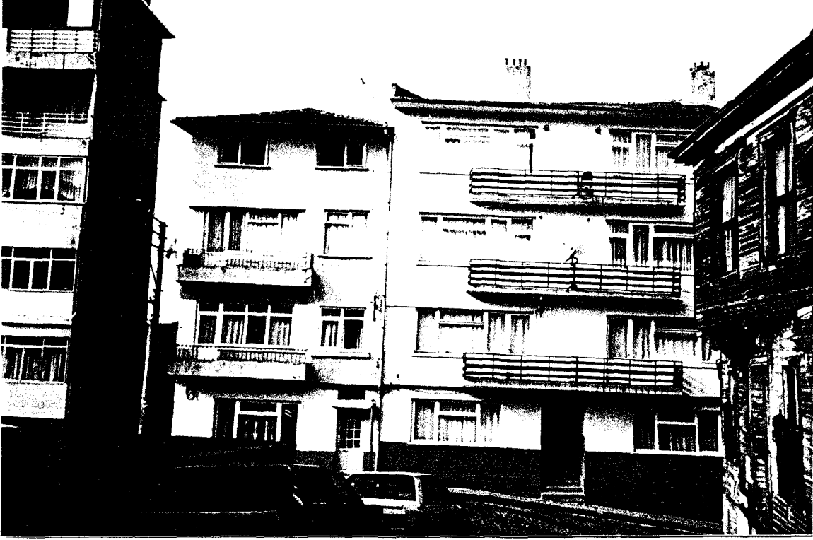
Fotoğraf 5-55 22 ada, 6 ve 7 parsellerdeki binalar.
