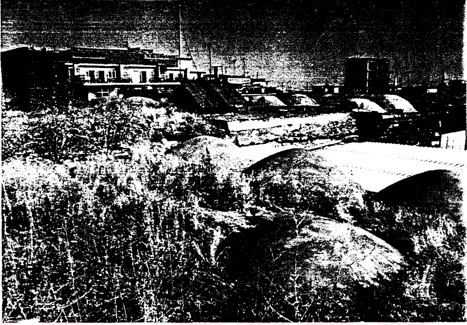
Resim 4.23. Han'ın Şapla Kaplanmış Tuğla Kubbeleri
