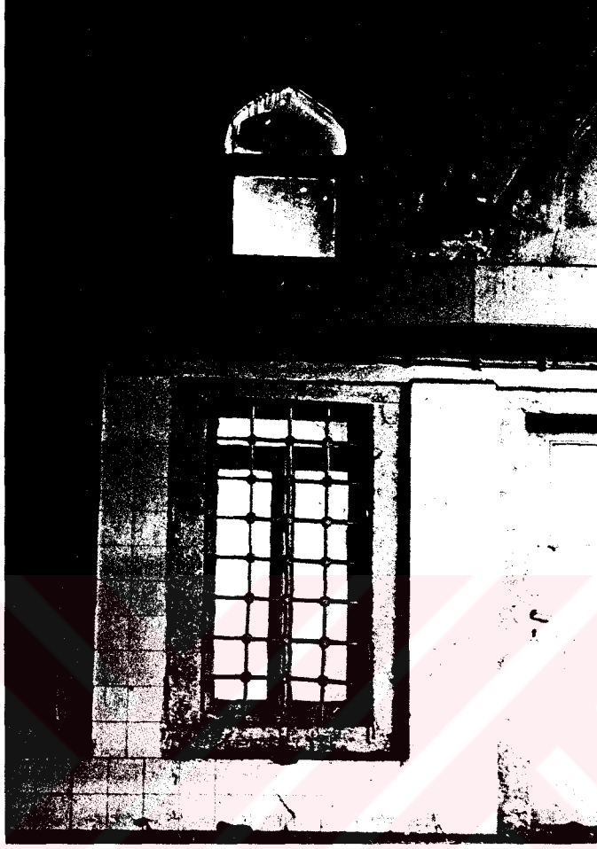
Resim 4.4. Avlu cephesine bakan pencerelerde yer alan demir şebekeler.
