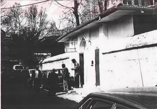
Resim 6.1. Cami avlu duvarı üzerinde yer alan ve wc olarak kullanılan yapı.
