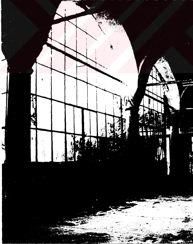
Resim 5.3.Revak kemerleri demir doğramalı camekanla kapatılmış
