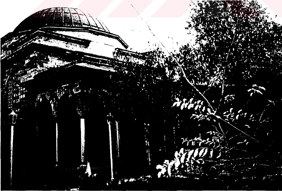
Resim 2.119. Hücrelerden ayrı olarak tasarlanan ve giriş revağı saçaklı bir çatıyla örtülen Yavuz Sultan Selim Medresesi'nin dershanesi.
