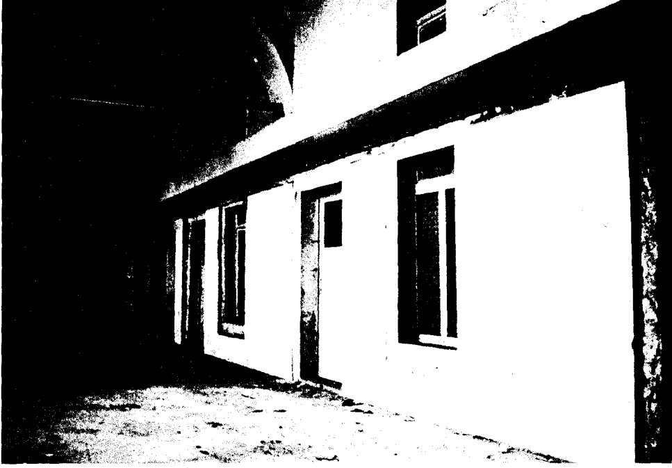
Resim 5.2. Hücrelerin avluya bakan cepheleri seramikle kaplanmış
