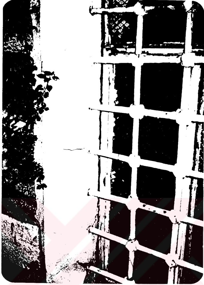
Resim 5.16. Pencere sövesi kırılmış ve parçalar kaybolmuş
