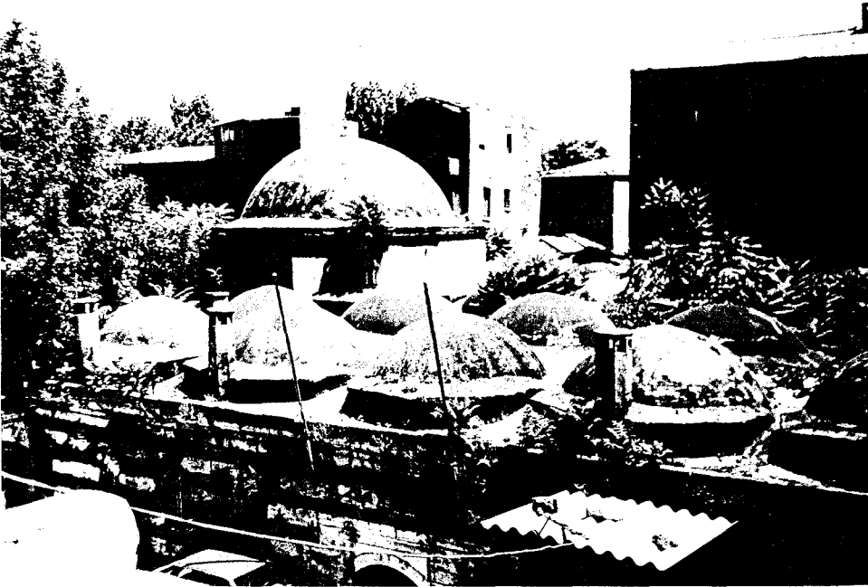
Resim 5.11. Kubbeler şap ile kaplanmış, kurşun örtü kaplaması ve alemleri yok
