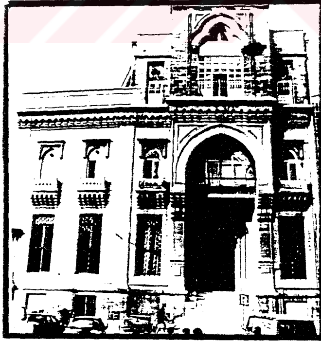
Şekil,2.55, Eminönü Osmanlı Bankası, giriş, A.Vallaury
