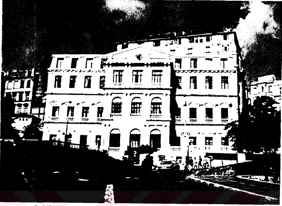
Şekil 2.30, Beyoğlu Belediye Binası
