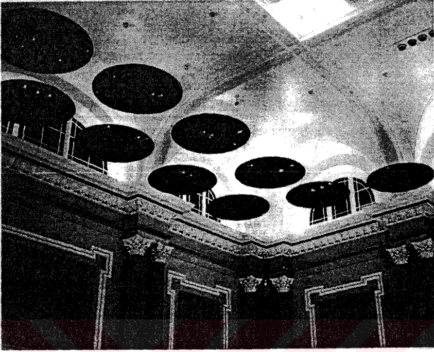
Resim 42. Sahne üstünde ilk yansımalarından yararlanmak amacıyla konulmuş akustik diskler
