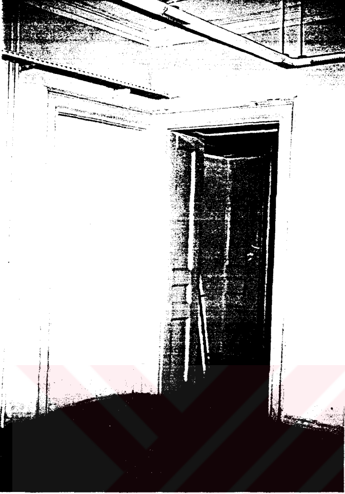
Fotoğraf 4.33. 1. katta kapatılan duvar kapı açıklıkları ( K1 12 ve K1 13)
