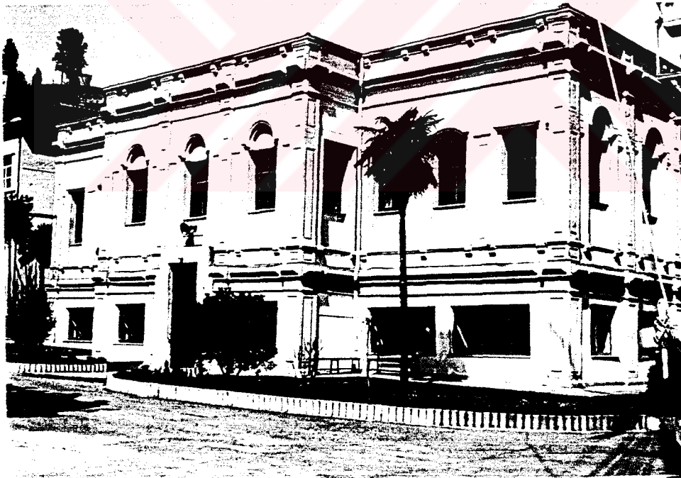
Fotoğraf 3.14. Yaverler Binası'nın Beşiktaş yönündeki cephesi
